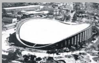
Figura 31 – Pavilhão São Cristóvão RJ 1958-1960. Fonte: < http://www.fireignsection.html >. Acesso em 05 mar. 2005.
