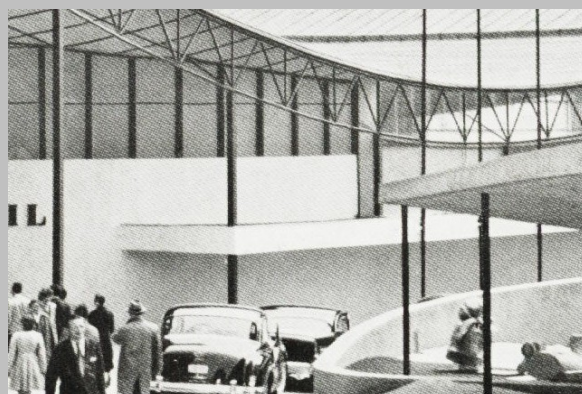
Figura 38 – Acesso de carros, rampa. Fonte: FRANK, 1961, p. 232.
