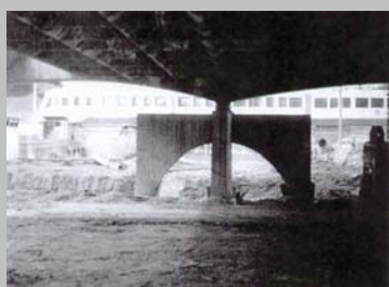
Figura 66 - Pavilhão Brasileiro Fonte: ARTIGAS, 2002, p. 78.
