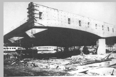
Figura 68 - Pavilhão Brasileiro Fonte: ARTIGAS, 2002, p. 78.
