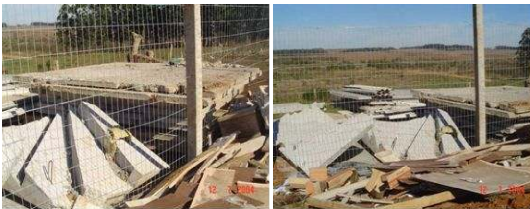
Figura 40: Lajes e escadas pré-moldadas danificadas.
