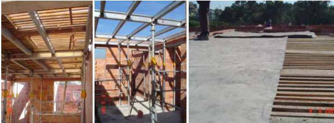
Figura 21: Sistema de formas da obra do Empreendimento 9.
