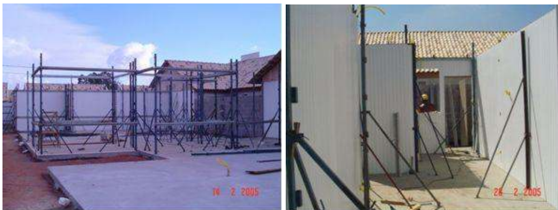
Figura 19: Montagem dos painéis de PVC do Empreendimento 7.
