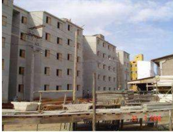
Figura 15: Foto do Empreendimento 4.
