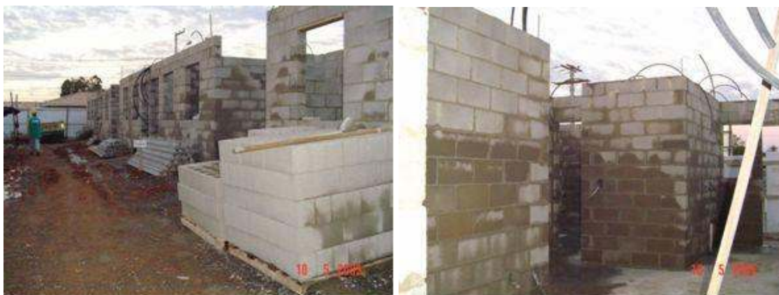
Figura 20: Execução das casas com alvenaria de blocos de concreto do Empreendimento 7.
