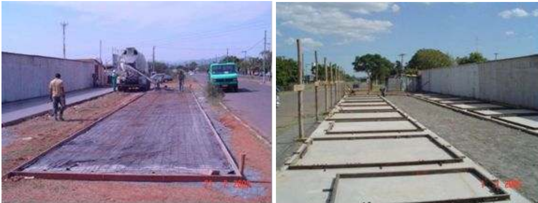
Figura 58: Área para produção de lajes da obra do Empreendimento 8.
