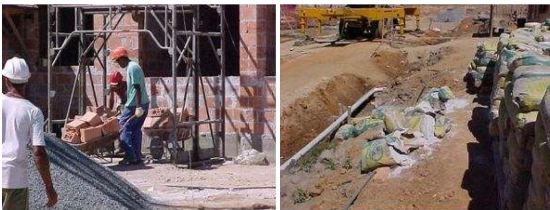
Figura 37: Perda por duplo transporte de blocos para o pavimento (à esquerda) e perda de material devido a estoque inadequado (à direita).
