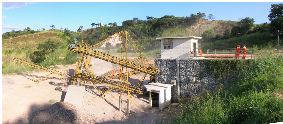
Figura 2.2: Central de reciclagem do Aterro (Belo Horizonte-MG).
