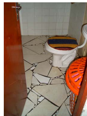
Fotografia 42: Mosaico de cerâmica no piso do banheiro Fevereiro 2007.
