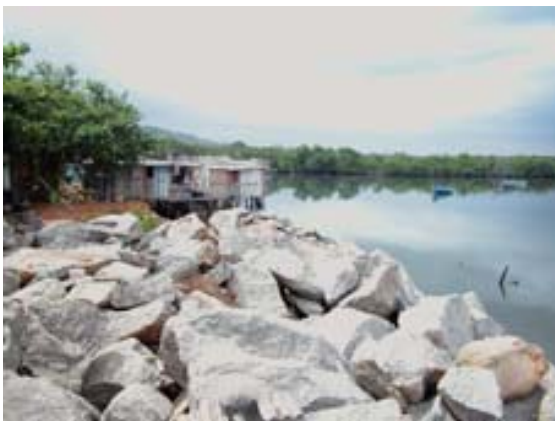
Fotografia 7: Trabalhos de enrocamento Fonte: ANTOLINI (2004d).
