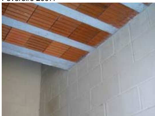
Fotografia 26: Laje pré-moldada, pavimento térreo Fevereiro 2007.
