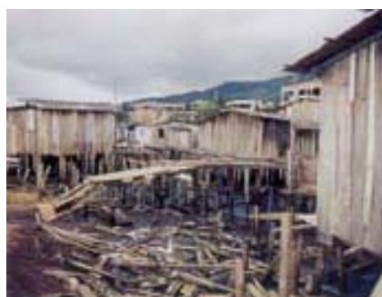
Figura 45: Demolição do "Passarelão" Fonte: MARTINUZZO (2002, p. 25).
