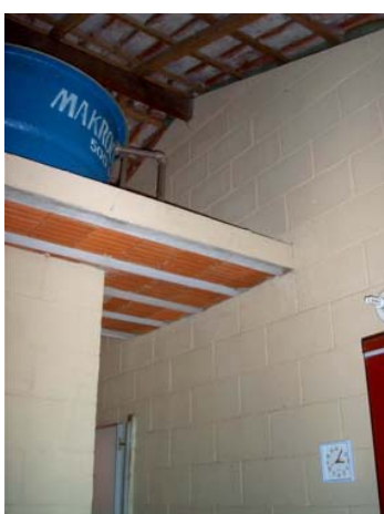
Fotografia 22: Caixa d'água posicionada sob o telhado Março 2007.
