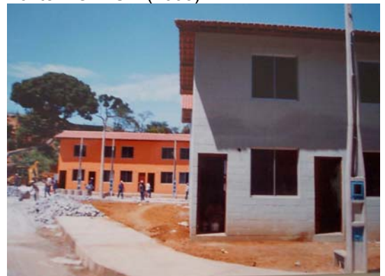
Fotografia 16: Pavimentação das calçadas Fonte: PAVIMENTAÇÃO... (2003).
