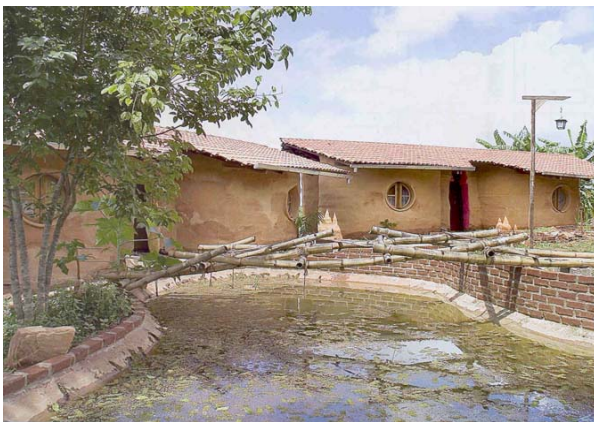
Figura 28: Casas feitas com superadobe Fonte: FIGUEROLA (2005, p. 29).
