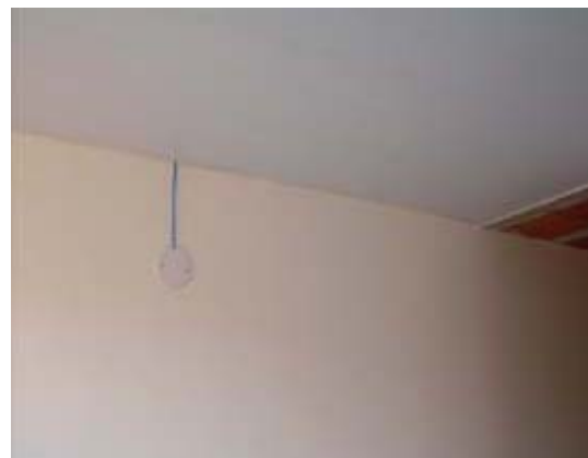
Fotografia 25: Habitação com forro de PVC Fevereiro 2007.
