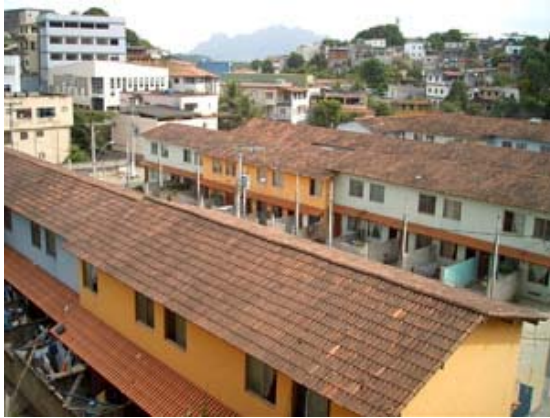
Fotografia 17: Vista geral da obra concluída Fevereiro de 2007.
