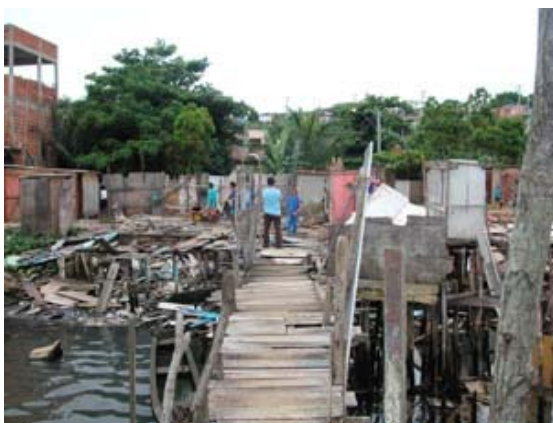
Fotografia 4: Início da demolição das palafitas Fonte: ANTOLINI (2004a).
