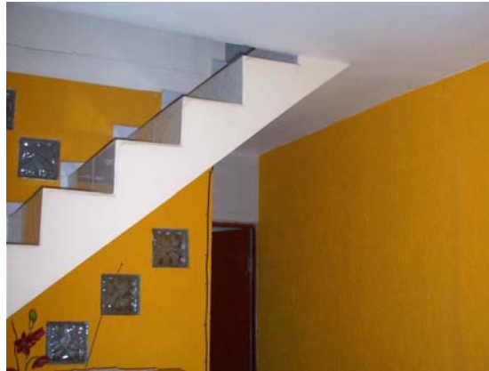
Fotografia 29: Paredes e teto rebocados e pintados em uma das habitações Março 2007.
