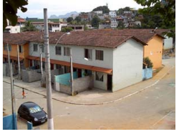
Fotografia 18: Casas habitadas em Barreiros Fevereiro de 2007.
