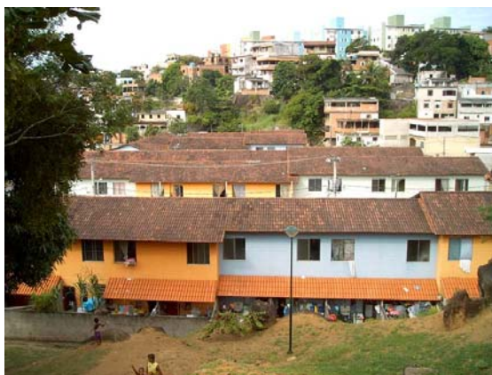
Fotografia 59: O conjunto está localizado em um vale Março 2007.
