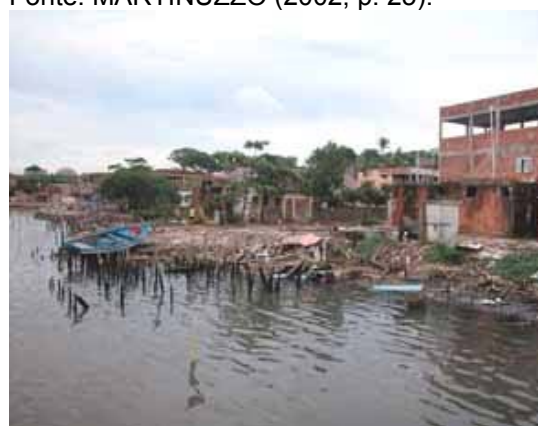
Fotografia 6: Cenário já com as palafitas desmanchadas Fonte: ANTOLINI (2004c).
