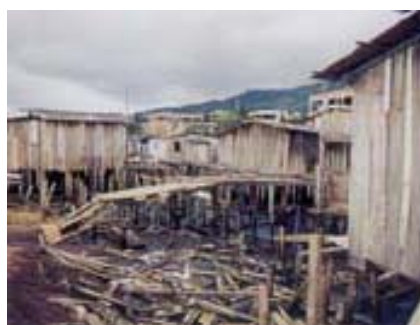
Figura 45: Demolição do "Passarelão" Fonte: MARTINUZZO (2002, p. 25).
