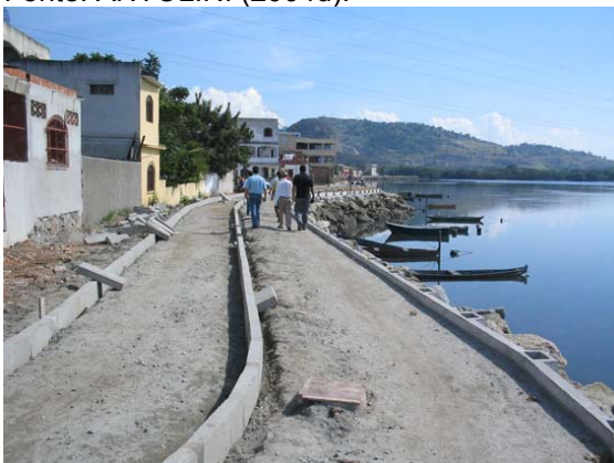
Fotografia 9: Construção de pistas para pedestres e ciclovias Fonte: CONSTRUÇÃO... (2003?).
