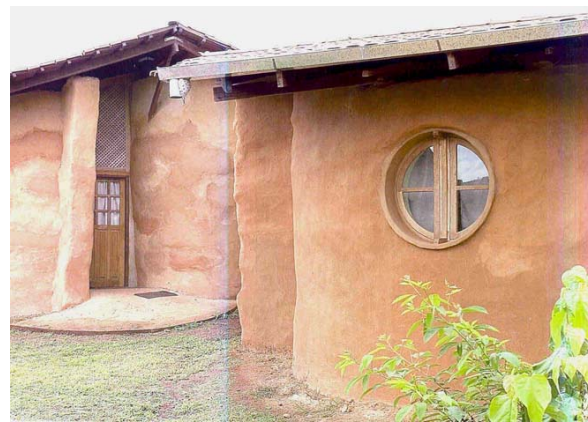
Figura 29: Paredes de superadobe com 40 a 60 cm de espessura Fonte: FIGUEROLA (2005, p.28).
