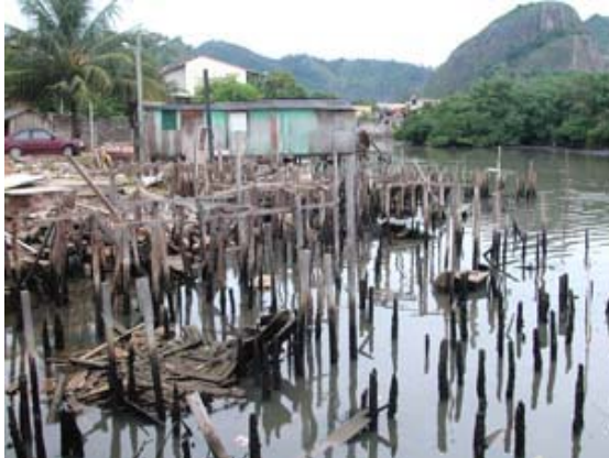
Fotografia 5: Fase final das demolições Fonte: ANTOLINI (2004b).
