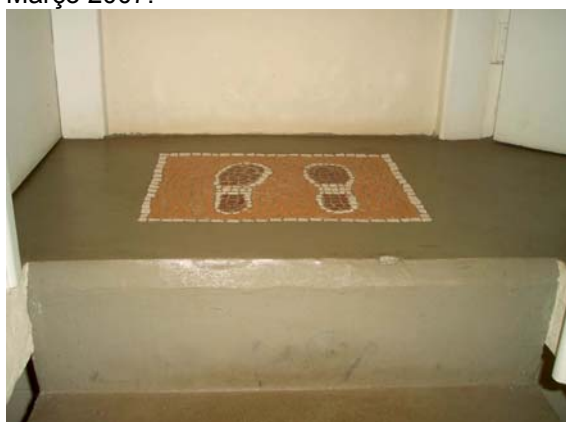
Fotografia 35: Mosaico de cacos de cerâmica no hall da escada do pavimento superior Março 2007.
