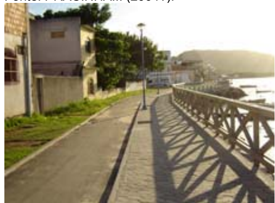
Fotografia 10: Pista de pedestres e ciclovia finalizadas Fonte: PISTA... (2004?).
