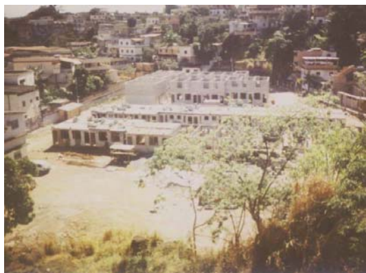
Fotografia 13: Construção do conjunto habitacional Fonte: CONSTRUÇÃO... (2002).
