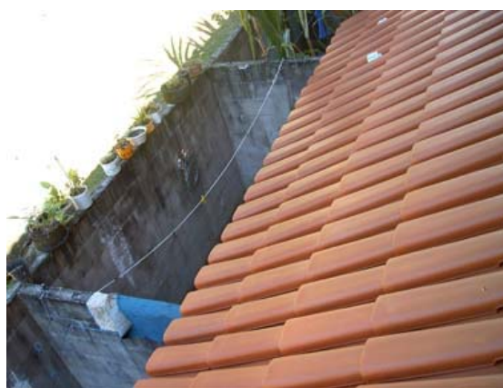
Fotografia 28: Vista superior da cobertura na área de serviços Março 2007.
