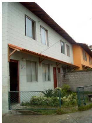
Fotografia 33: Casa modelo com jardim também executado Março 2007.
