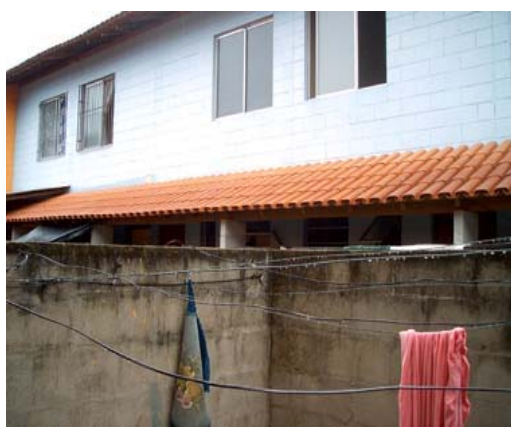
Fotografia 27: Cobertura na área de serviços Março 2007.
