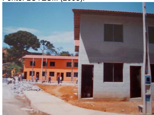
Fotografia 16: Pavimentação das calçadas Fonte: PAVIMENTAÇÃO... (2003).
