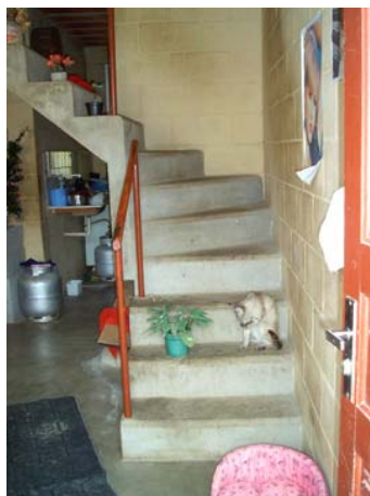
Fotografia 68: Piso e escada: acabamento em cimento liso Março 2007.
