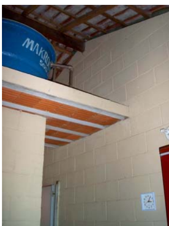
Fotografia 22: Caixa d'água posicionada sob o telhado Março 2007.
