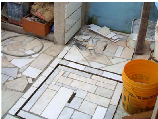
Fotografia 30: Aproveitamento de materiais - pavimentação total do terreno Março 2007.
