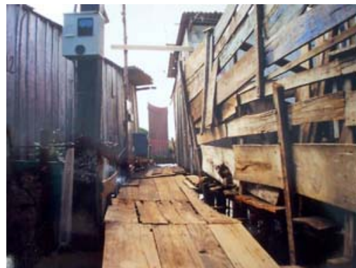
Fotografia 3: “Passarelão” dava acesso às palafitas Fonte: PASSARELÃO... (2002?).
