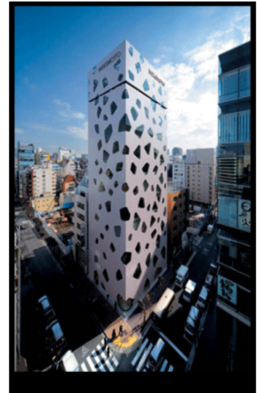
Edifício Glass Boulder Tower , arq. Toyo Ito Fonte: www.my.opera.com 21.Jun.06
