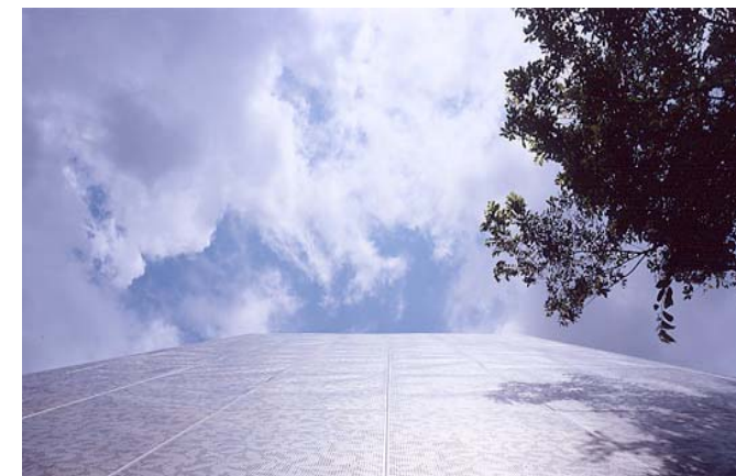
Sfera Building, arq. Eero Koivisto Acima e ao centro: detalhe da estampa em microfuros. Abaixo: detalhe da fachada e sombreamento da cerejeira. Fonte: www.professionearchitetto.it 12.Set.06
