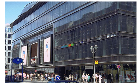
Galeria Lafayette, Frieederichstrasse, arq Jean Nouvel Fonte: www.galerielafayette.de 17.Out.05
