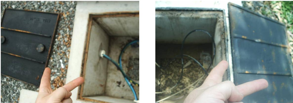
Fig. 36 – Exemplos de corrosão atmosférica em um site de telefonia celular [54].
