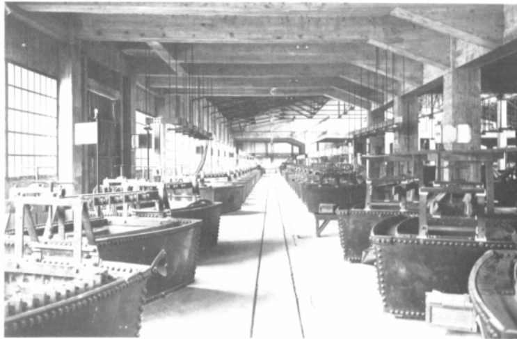
Figura 3: Uma linha de cubas de 600 A em 1917 – reproduzido de Grjotheim e Welch (1988).
