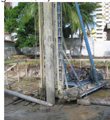
Figura 6 - Bate estacas
