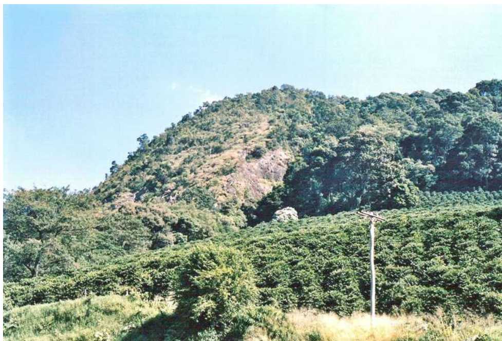
Figura 46. Talude convexo na estrada Poços de Caldas – Águas da Prata (Santa Rita do Quartel). Localização: Próximo ao ponto 30 no Anexo 1.
