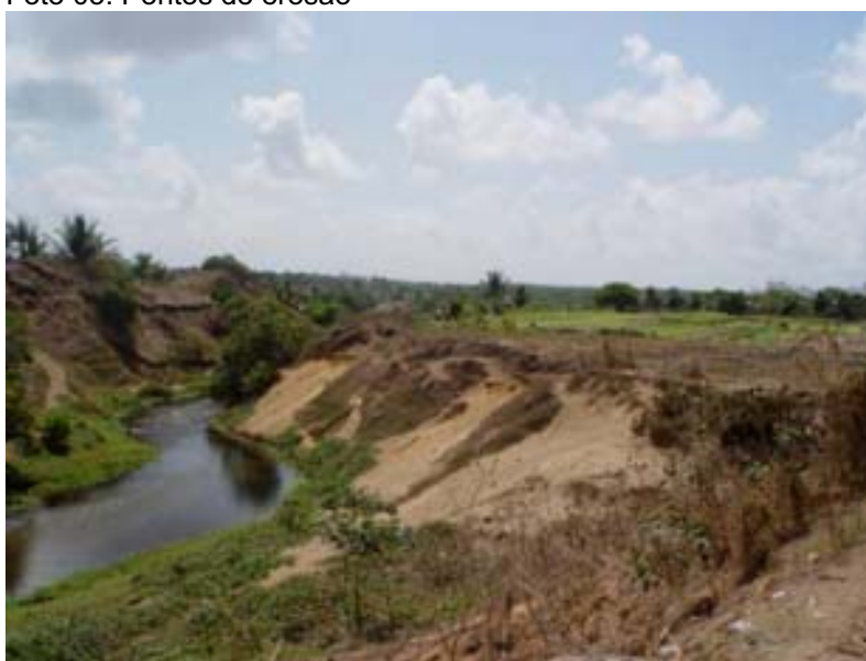
Foto 03: Pontos de erosão
