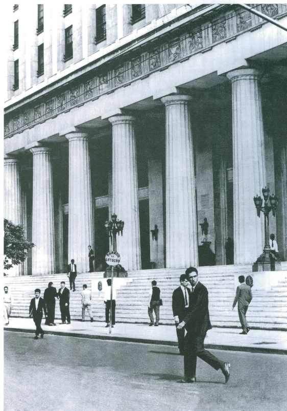
FIGURA 10 – Ministério da Fazenda (Rio de Janeiro-RJ) Fonte: CAVALCANTI, 2006, p. 75.
