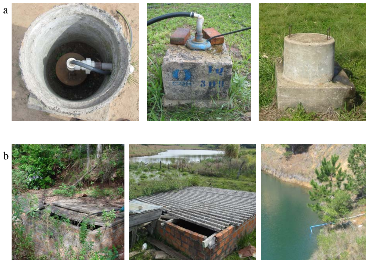
Figura 5 – Sistemas de captação de água de algumas escolas e comunidades rurais da Região Central do RS. (a) Poços tubulares; (b) Sistemas periféricos.
