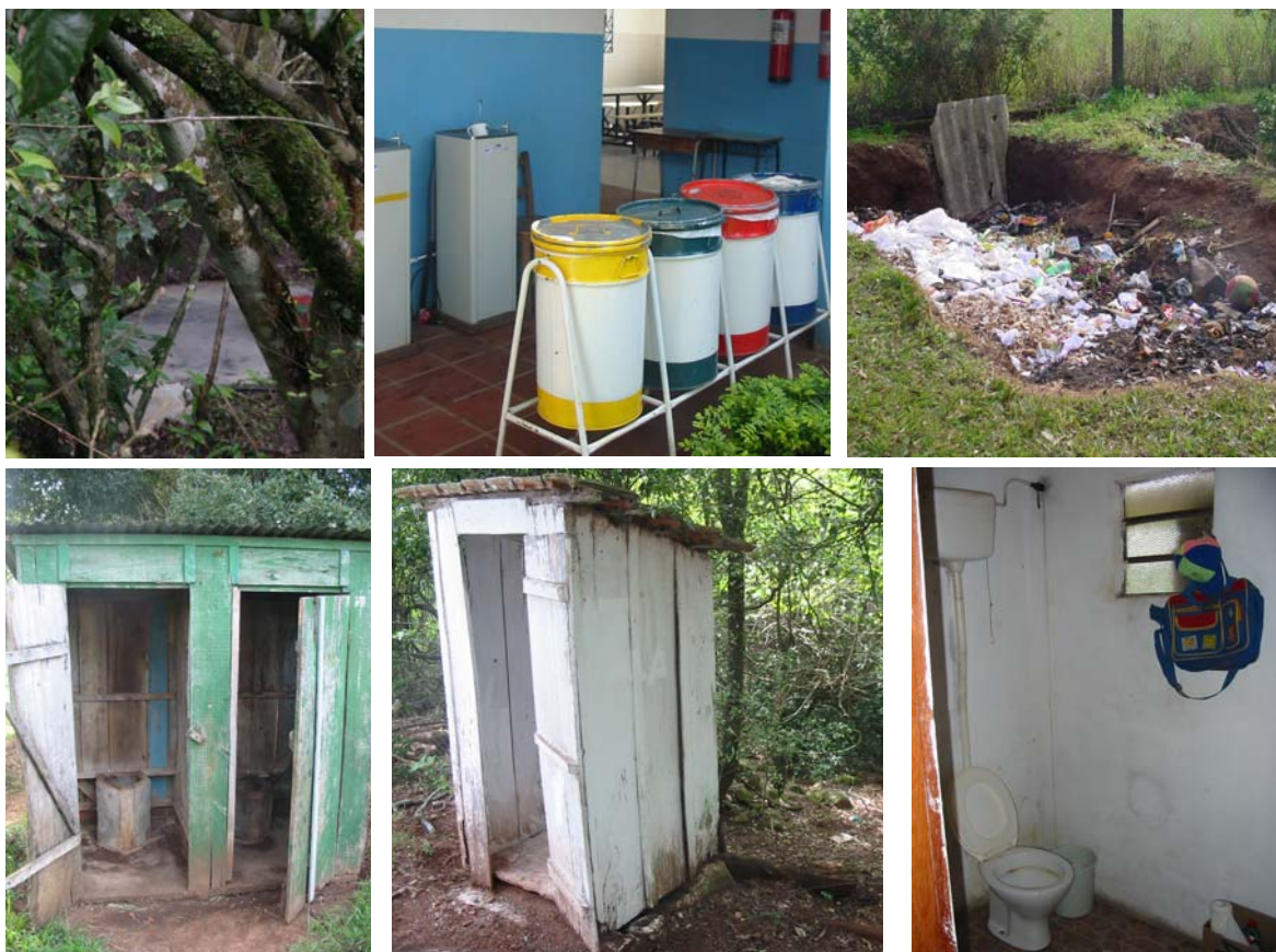
Figura 7 – Sistemas de coleta de esgoto e descarte de lixo de algumas escolas e comunidades rurais da Região Central do RS.
