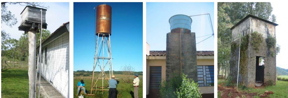
Figura 6 – Sistemas de armazenamento de água de algumas escolas e comunidades rurais da Região Central do RS.
