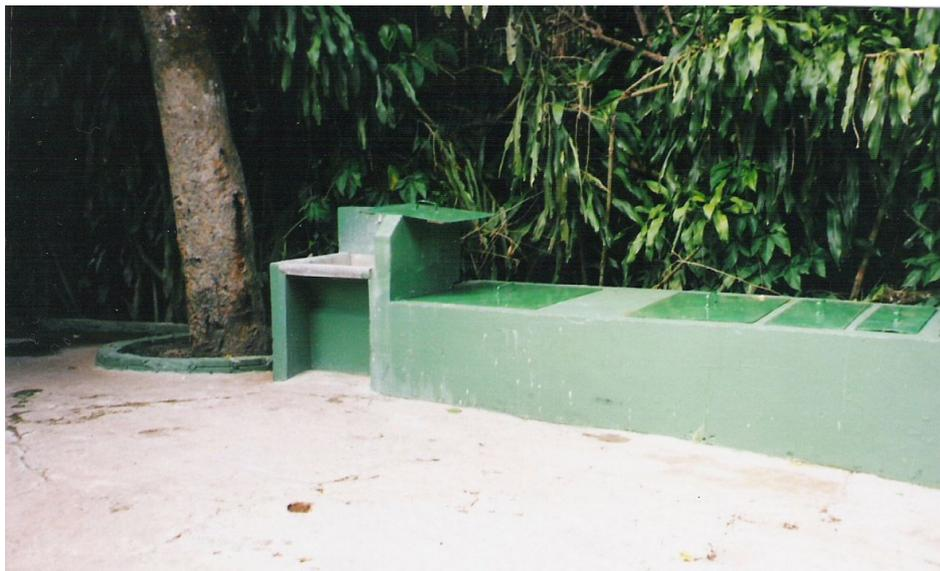
Foto 14: Mini-estação de tratamento de resíduos de tintas e materiais de construção. (Sílvia C. Goya, 2006)
