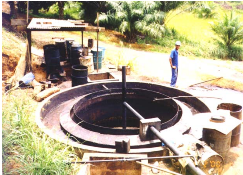
Figura 2.42: Estrutura de recuperação final de óleo de palma em efluentes
