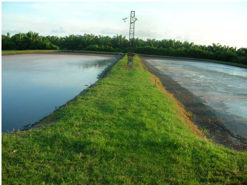
Figura 2.46: Lagoa de tratamento de efluentes na Colômbia
