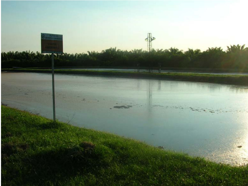
Figura 2.45: Lagoa de tratamento de efluentes na Colômbia
