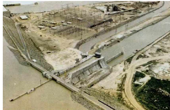
Figura 5.13 – Construção da Eclusa do reservatório de Sobradinho (Fonte: www.ahsfra.gov.br/640/eclusa3.htm , 2007).
