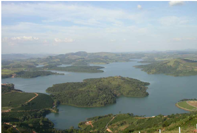
Figura 7.30 - Vista do reservatório em período que está cheio (Fonte: Prefeitura Municipal de Caconde, 2005).
