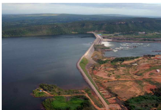
Figura 5.7 - Imagem aérea da barragem do reservatório de Lajeado (Fonte: INVESTCO, 2007).
