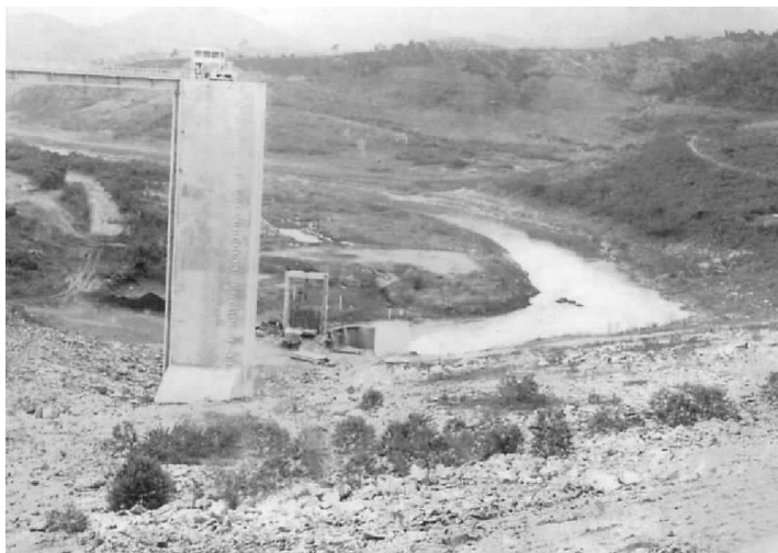
Figura 7.25 - Construção do vertedor Tulipa em 1965 (Fonte: Foto cedida por Forlin, 2005).
