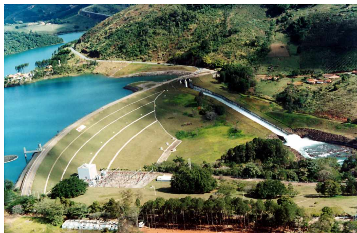
Figura 5.28 - Barragem do reservatório de Caconde (Fonte: www.aestiete.com.br , 2005).
