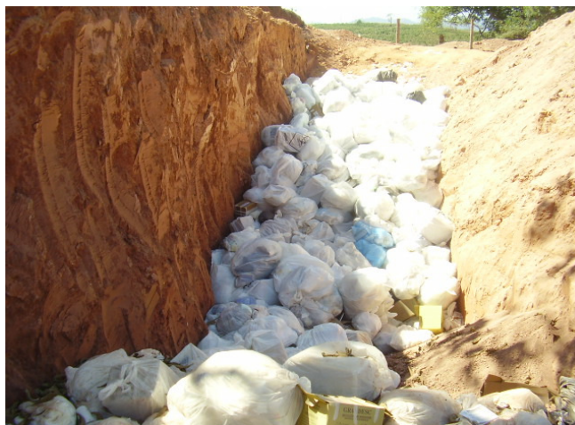
Figura 11: Disposição final dos RSS do HCL na vala
