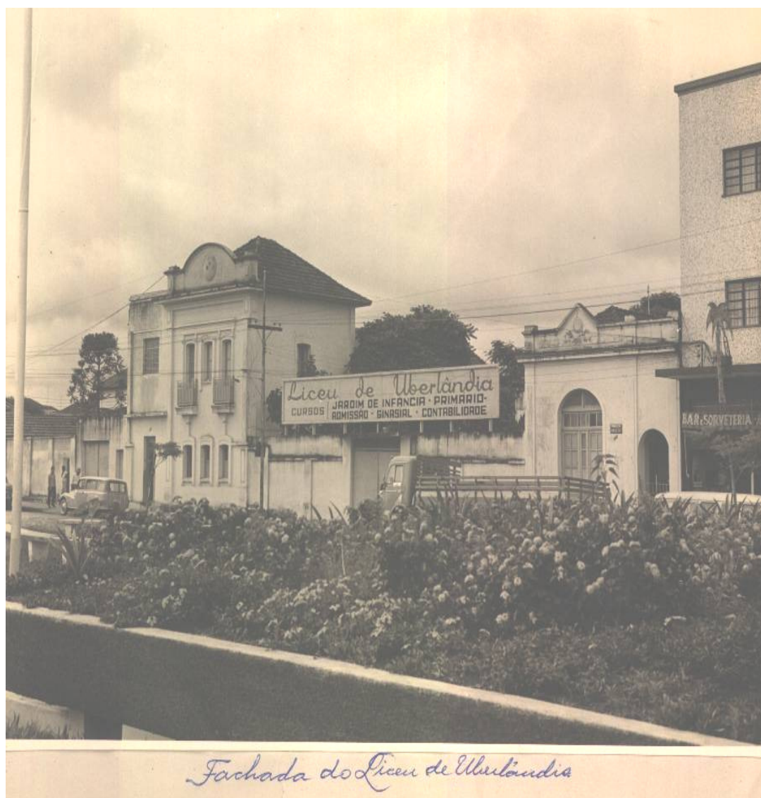
Figura 5 – Fachada do Liceu de Uberlândia
