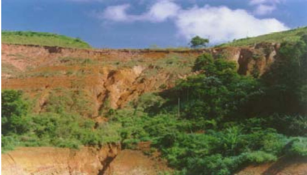
Figura 11: Processo de erosão no talude do Salvaterra próximo à BR-040, indicando a instabilidade do terreno (janeiro de 2005). Fonte: DEMLURB, 2007b.
