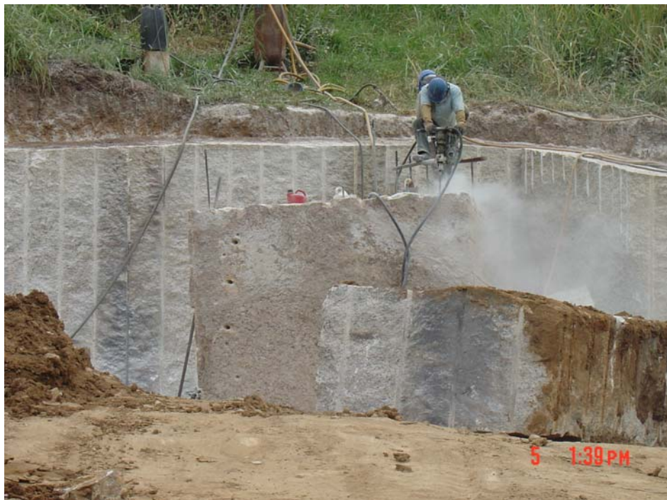
Foto 3 Trabalhador perfurando a rocha, exposição ao pó de minério
