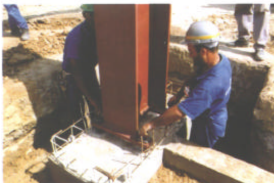
Figura 4.24 – Sede do Tribunal de Contas da União no Estado do Espírito Santo – CTRS – Vitória, ES, Brasil, 1998. Arquiteto: João Filgueiras Lima, Lelé. Croqui – concepção estrutural do edifício. Fixação dos pilares tipo “I” engastados na base. Vigas duplas de aço apoiadas sobre os pilares tipo “I”.
