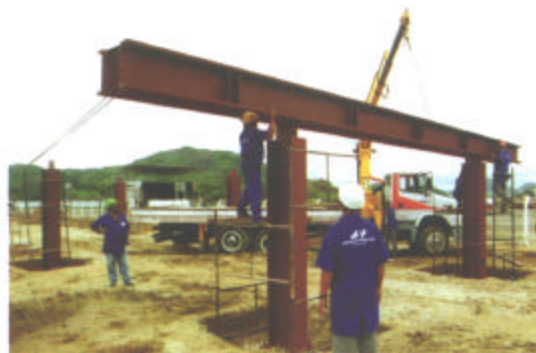
Figura 4.24 – Sede do Tribunal de Contas da União no Estado do Espírito Santo – CTRS – Vitória, ES, Brasil, 1998. Arquiteto: João Filgueiras Lima, Lelé. Croqui – concepção estrutural do edifício. Fixação dos pilares tipo “I” engastados na base. Vigas duplas de aço apoiadas sobre os pilares tipo “I”.
