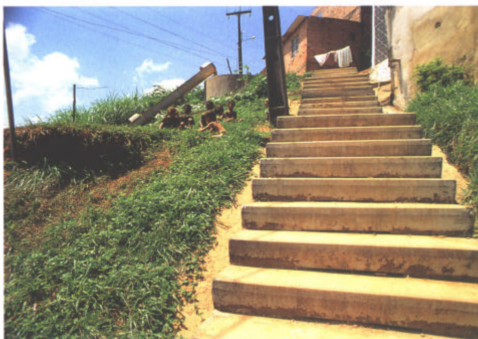
Figura 4.16 – Renurb – Pré Fabricação em Argamassa Armada. Saneamento Básico em Salvador – Salvador, BA, Brasil, 1980-82. Arquiteto: João Filgueiras Lima, Lelé. Drenagem secundária.
