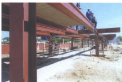
Figura 4.27 – Sede do Tribunal de Contas da União no Estado do Espírito Santo – CTRS – Vitória, ES, Brasil, 1998. Arquiteto: João Filgueiras Lima, Lelé. Vigas de piso mistas (aço-concreto). Vistas dos pórticos principais montados. Colocação das lajes pré-fabricadas sobre as vigas de piso.
