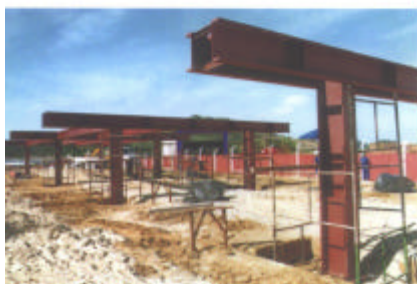
Figura 4.27 – Sede do Tribunal de Contas da União no Estado do Espírito Santo – CTRS – Vitória, ES, Brasil, 1998. Arquiteto: João Filgueiras Lima, Lelé. Vigas de piso mistas (aço-concreto). Vistas dos pórticos principais montados. Colocação das lajes pré-fabricadas sobre as vigas de piso.
