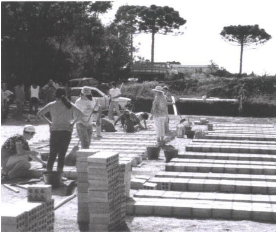
Figura 4.36 – CPC - Construção com Pré-fabricados Cerâmicos. Detalhes do primeiro e segundo protótipos de residências desenvolvidas por Villà e Yopanan Rebello no campus da Unicamp. Vista do canteiro em Vernópolis, RS.
