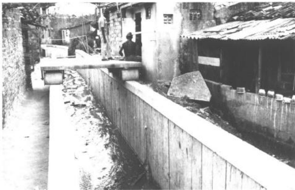
Figura 4.18 – Renurb – Pré Fabricação em Argamassa Armada. Saneamento Básico em Salvador – Salvador, BA, Brasil, 1980-82. Arquiteto: João Filgueiras Lima, Lelé. Drenagem de canal.
