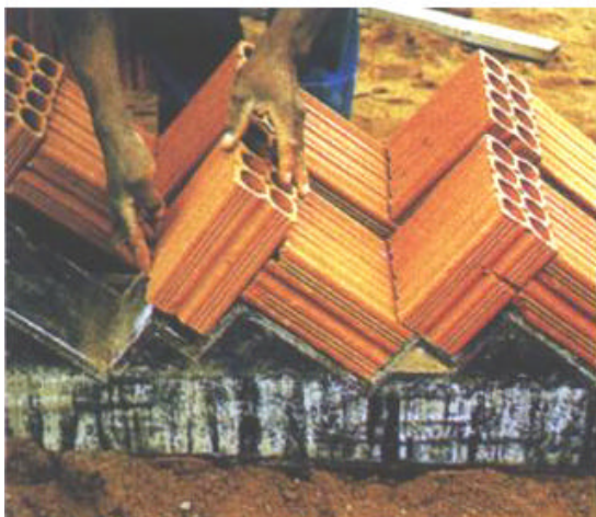
Figura 4.35 – CPC - Construção com Pré-fabricados Cerâmicos. Módulos pré-fabricados constituídos de painéis de tijolos cerâmicos solidarizados.
