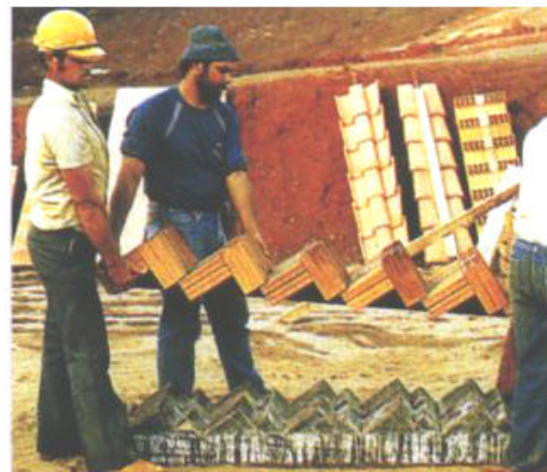
Figura 4.35 – CPC - Construção com Pré-fabricados Cerâmicos. Módulos pré-fabricados constituídos de painéis de tijolos cerâmicos solidarizados.
