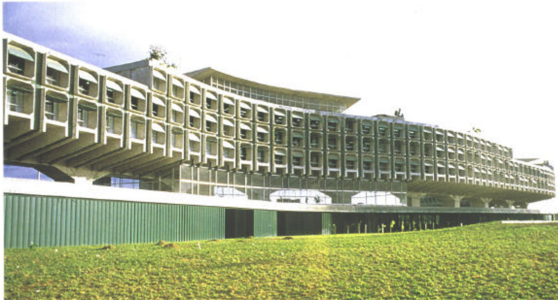
Figura 4.14 – Secretarias do Centro Administrativo da Bahia – Salvador, BA, Brasil, 1973. Arquiteto: João Filgueiras Lima, Lelé. Fotos do edifício.
