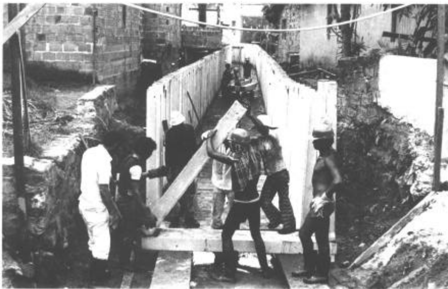
Figura 4.17 – Renurb – Pré Fabricação em Argamassa Armada. Saneamento Básico em Salvador – Salvador, BA, Brasil, 1980-82. Arquiteto: João Filgueiras Lima, Lelé. Drenagem de canal.
