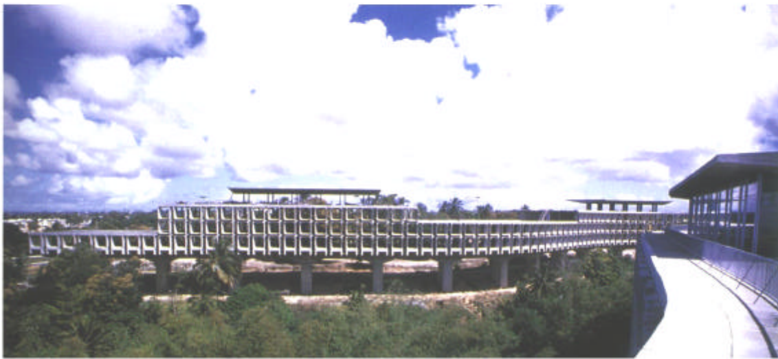
Figura 4.13 – Secretarias do Centro Administrativo da Bahia – Salvador, BA, Brasil, 1973. Arquiteto: João Filgueiras Lima, Lelé. Fotos do processo de construção.
