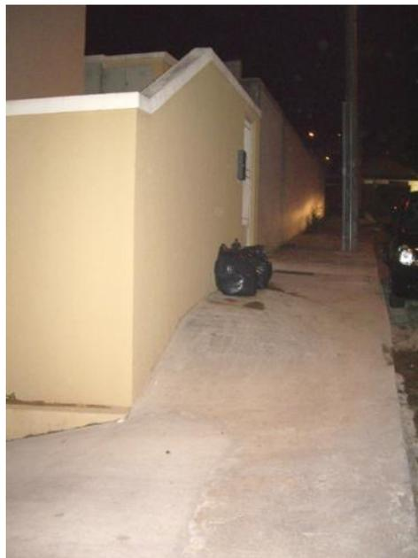
**Figura 31:** Calçada com desnível inadequado - Edifício 13
