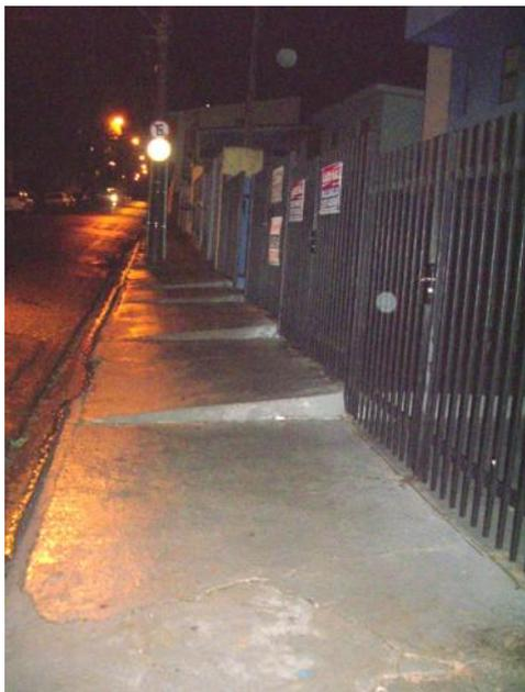
**Figura 30:** Calçada com desnível inadequado - Edifício 6
