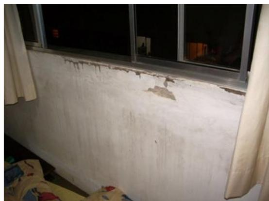
**Figura 77:** Infiltração em parede de sala - Edifício 1
