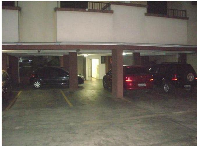
**Figura 35:** Ausência de faixa de acesso para pedestres - Edifício 2
