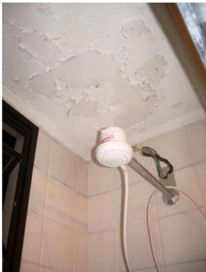
Figura 78: Pintura danificada causada por umidade de banheiro - Edifício 2
