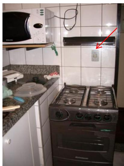
**Figura 74:** Disposição inadequada de interruptor - Edifício 6
