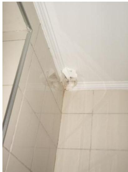
Figura 79: Fissura em forro de gesso - Edifício 2
