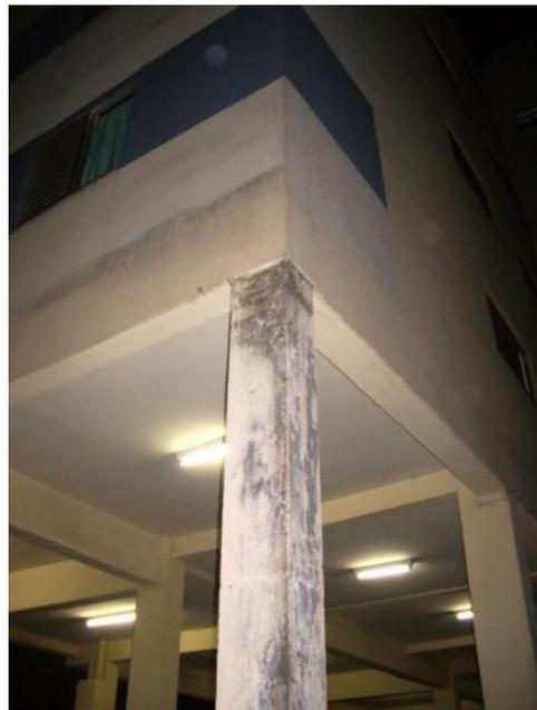
**Figura 51:** Infiltração e mancha em pilares do térreo (garagem) - Edifício 1
