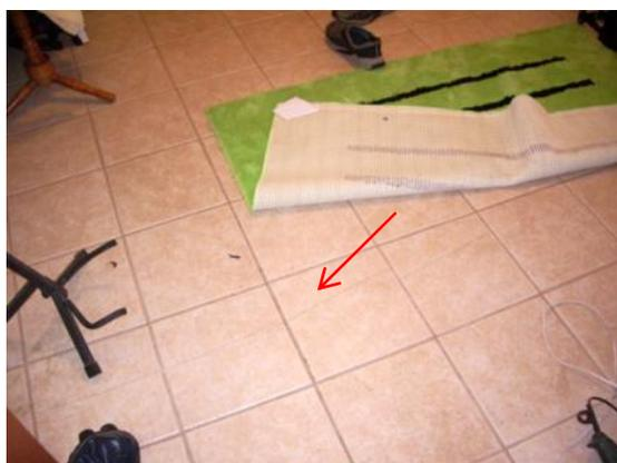
Figura 75: Trincas no revestimento cerâmico - Edifício 10
