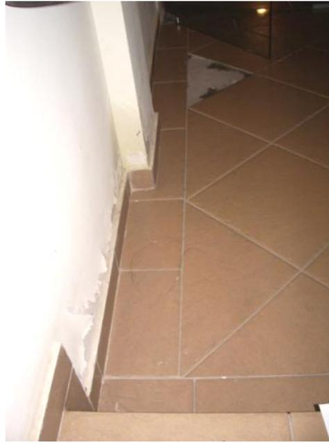
**Figura 49:** Piso retirado para corrigir nivelamento que impede abertura da porta de acesso / pintura danificada - Edifício 13
