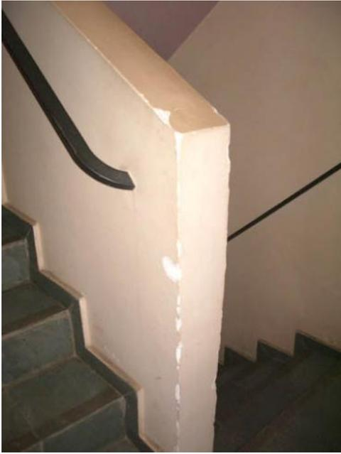
**Figura 48:** Revestimento solto e pintura danificada na caixa de escada - Edifício 4
