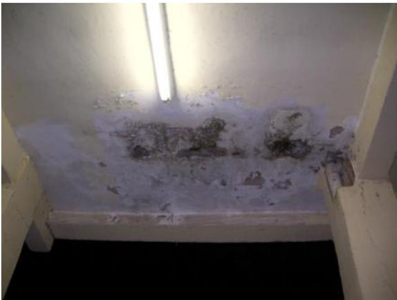
**Figura 50:** Infiltração e mancha na laje do térreo (garagem) - Edifício 1
