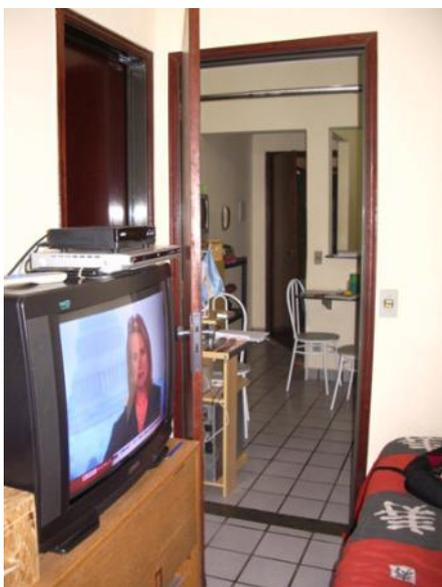
Figura 66: Portas que interferem entre si quando abertas - Edifício 5
