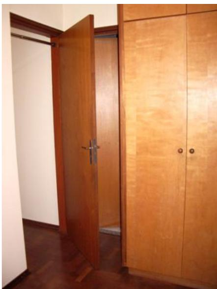
Figura 65: Portas que interferem entre si quando abertas - Edifício 6
