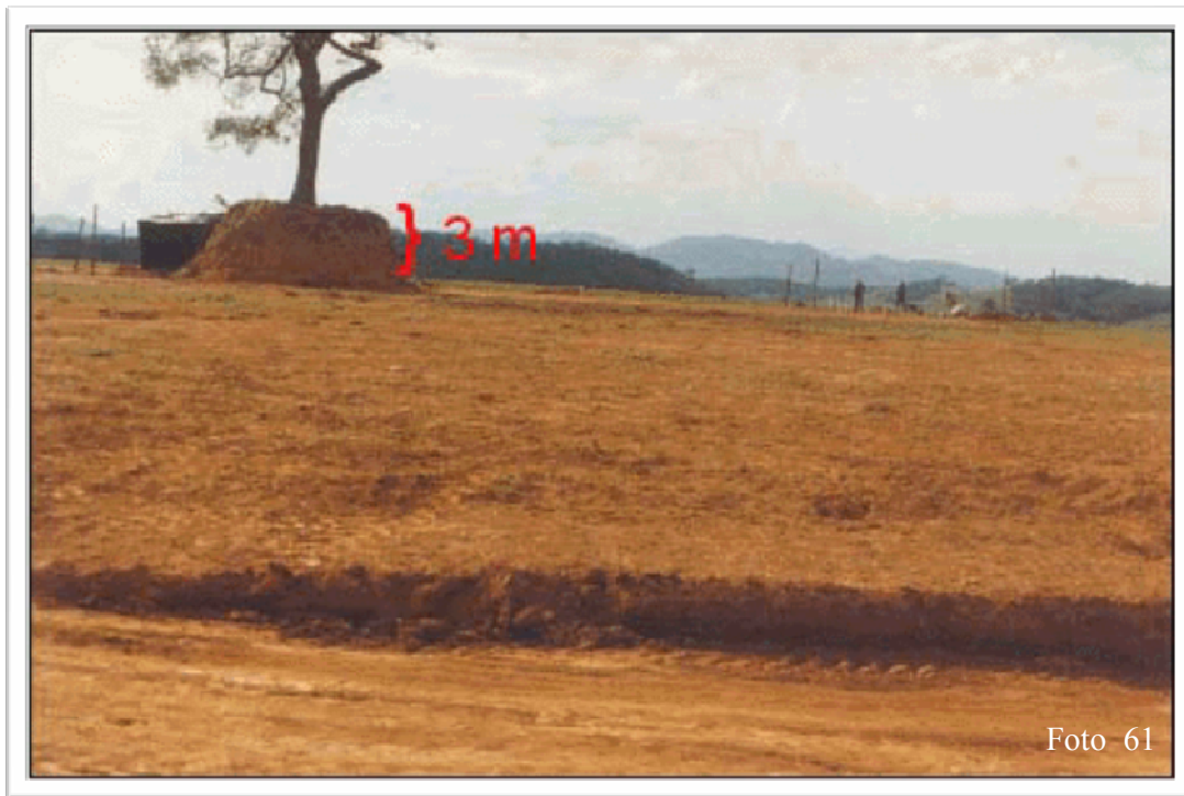
Fonte: (Kneip & Crancio 2001). Sítio impactado após terraplanagem.
