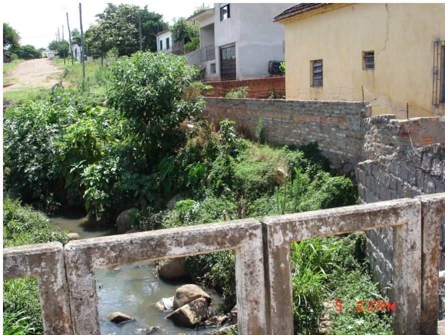
Fotografia 8 – Aspecto da impermeabilização do Lajeado do Moinho ao longo do Bairro Kurtz. Fonte: Trabalho de campo, 2006.
