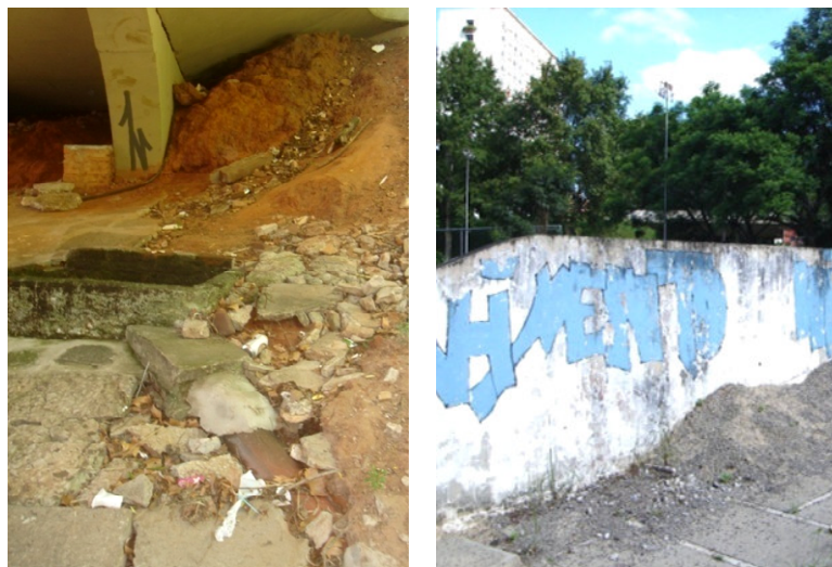
Figuras 41 e 42 – O Poder público também é responsável: além da pichação usual, o material de construção amontoado na calçada do Setor 2 (à esquerda), e calçadas quebradas e lixo amontoado embaixo do viaduto da rua Venâncio Aires
