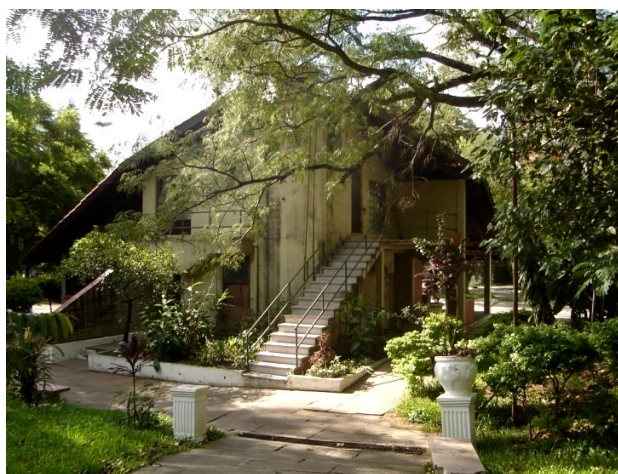
Figura 22 – O quiosque do Setor 5, praticamente abandonado, serve em geral como abrigo para moradores de rua
