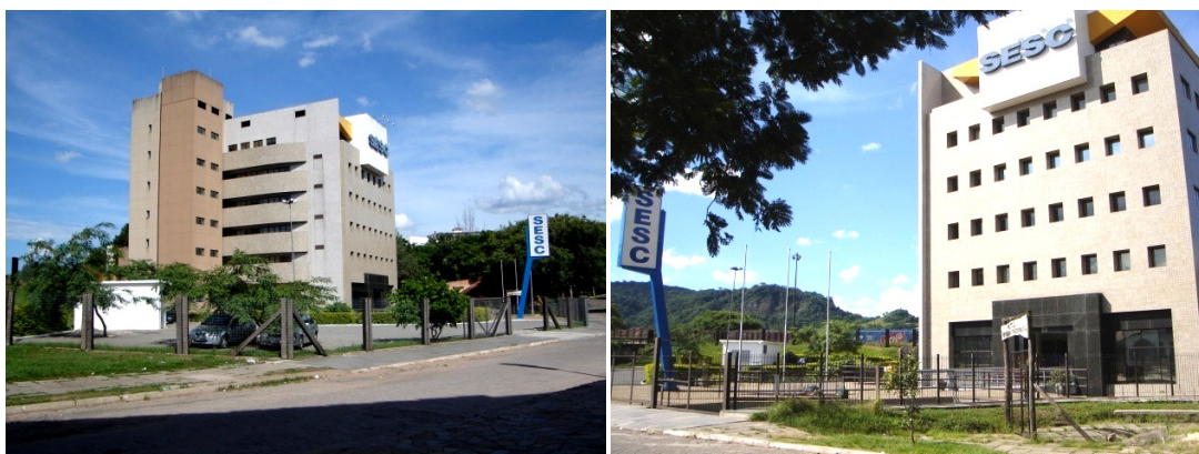
Figuras 19 e 20 – Prédio do SESC no Setor 1, cuja construção inviabilizou qualquer nova proposta para aproveitamento da antiga estrutura da ponte
