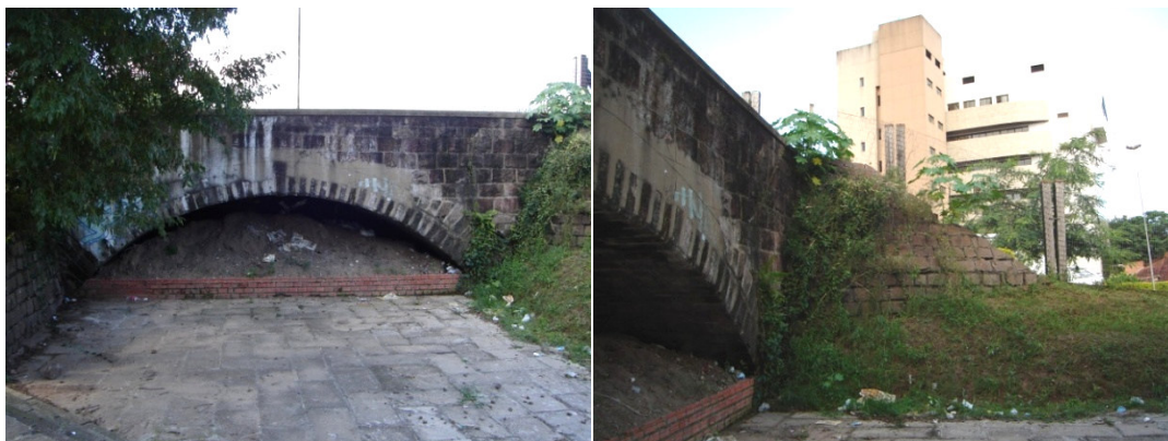
Figuras 17 e 18 – Antiga ponte de pedra da ferrovia no Setor 1, abandonada e descaracterizada
