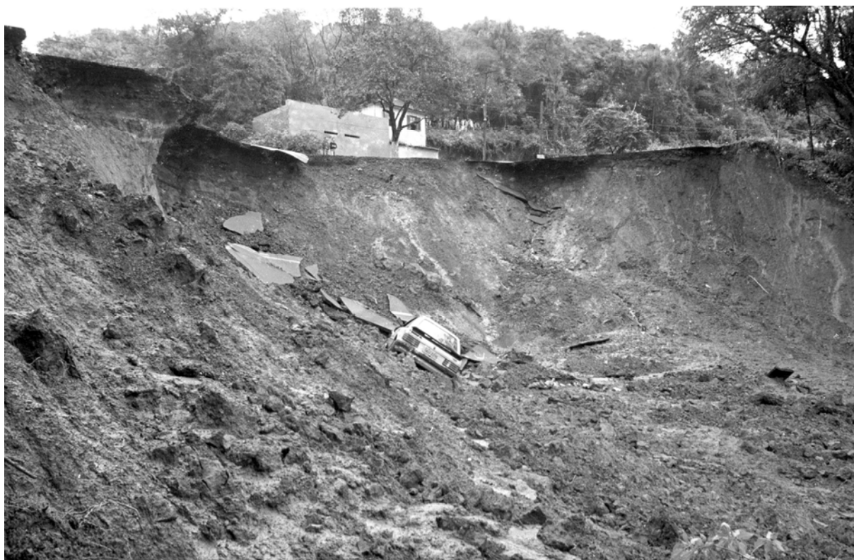
Figura 6.6 – Deslizamento de parte do aterro de uma rodovia no município de Estância Velha em julho de 1993. Fonte: Banco de dados do Jornal Zero Hora. Fotógrafo: Ronaldo Bernardi.
