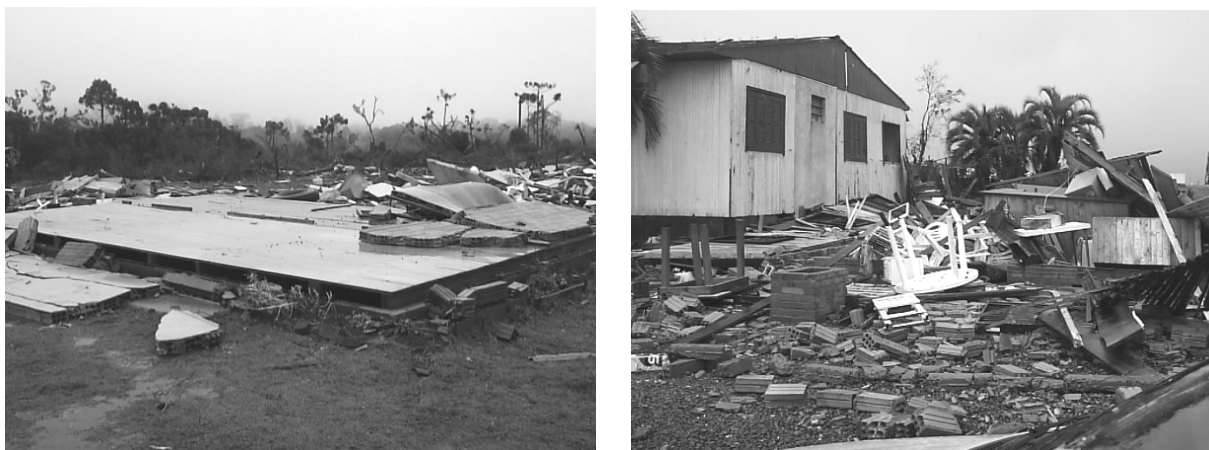
Figuras 6.21 e 6.22 - Moradias destruídos pelo tornado que atingiu Muitos Capões em agosto de 2005 Fonte: Defesa Civil do Estado do Rio Grande do Sul. Disponível em: < http://www.defesacivil.rs.gov.br >.
