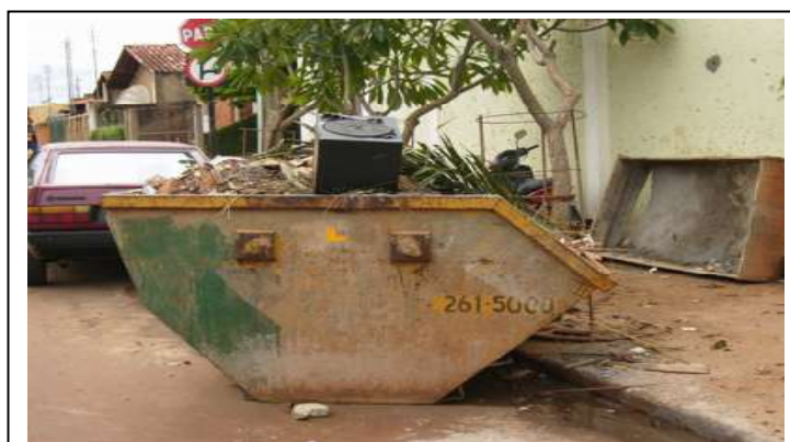
FIGURA 4.20 – Falta de sinalização na caçamba
