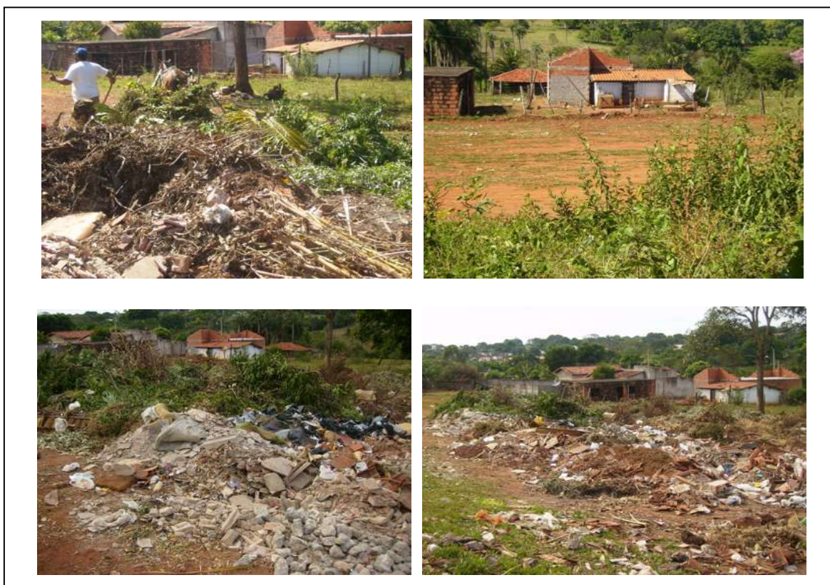
FIGURA 4.15 – Residências próximas à área do depósito provisório – ausência de cercas, risco de vetores e de doenças.
