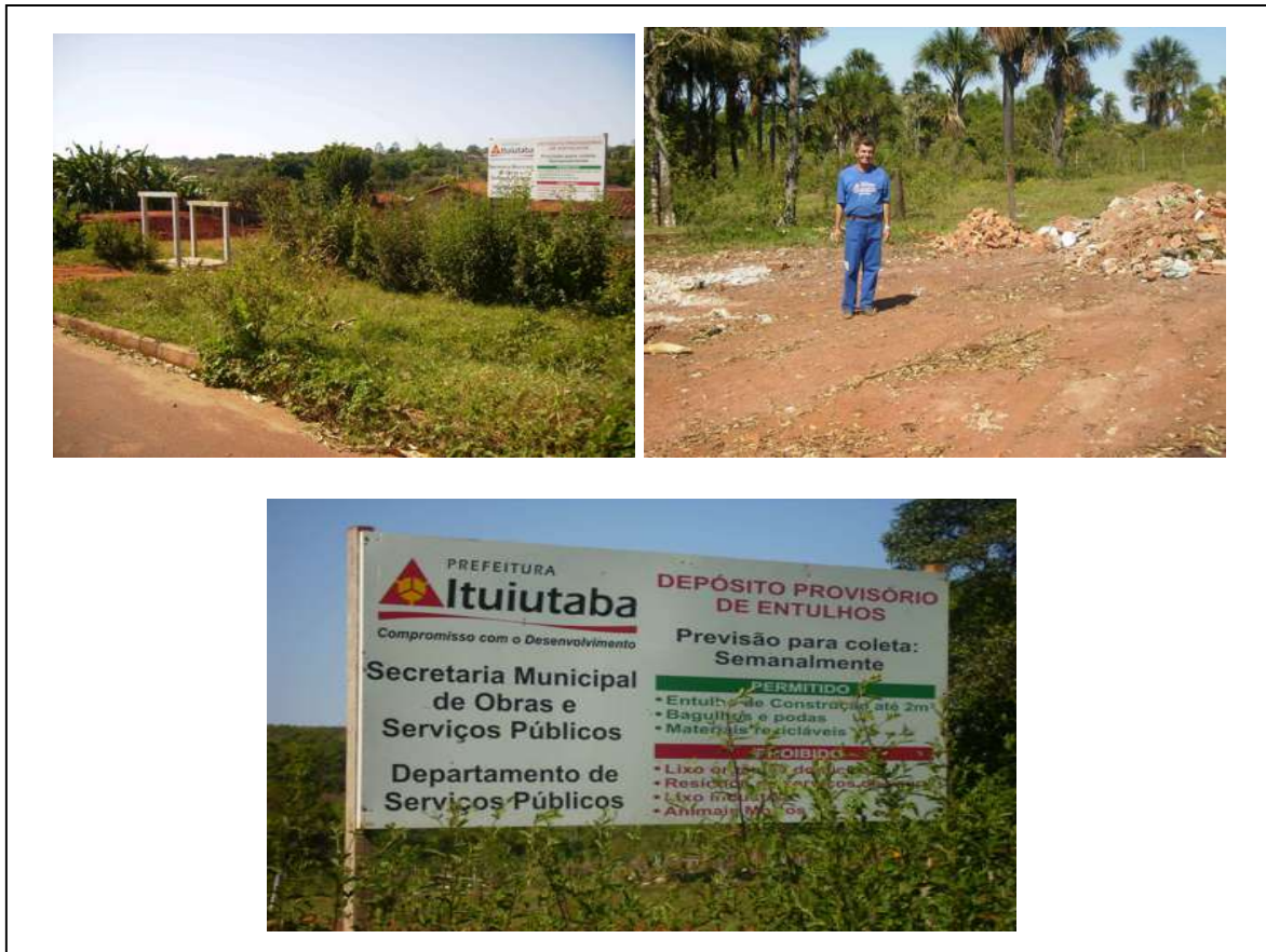
FIGURA 4.10 – Indicação do depósito provisório de RCD – presença do funcionário responsável e falta de guarita, cercas e vegetação protetora adequada.
