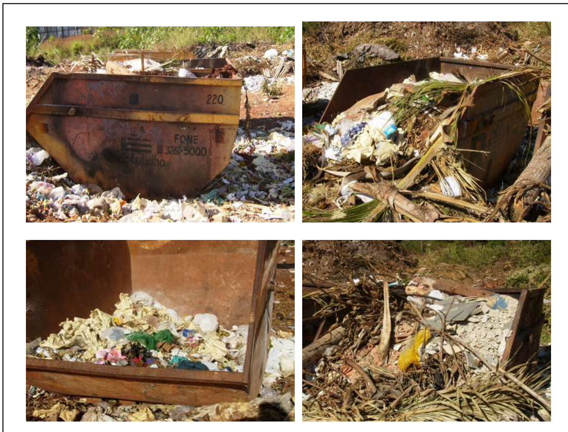
FIGURA 4.23 – Utilização inadequada das caçambas: resíduos depositados do lado de fora, resíduos domésticos e recicláveis misturados ao RCD.
