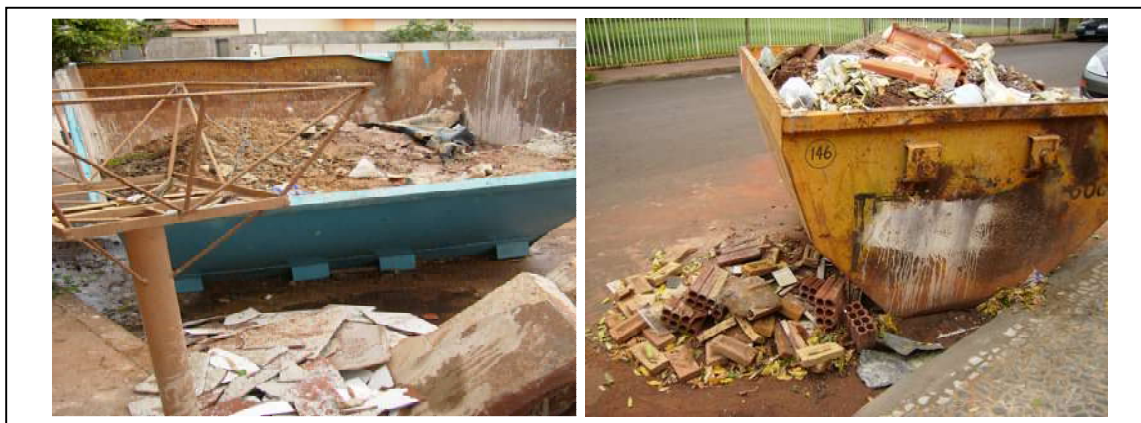
FIGURA 4.19 – Resíduos de uma obra depositados fora das caçambas.
