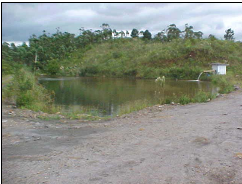
Figura 8– Detalhe da bacia de precipitação. Ao fundo detalhe da adição de soda caustica e cal. Fonte: Jairo José Zocche e Micheli de Freitas.
