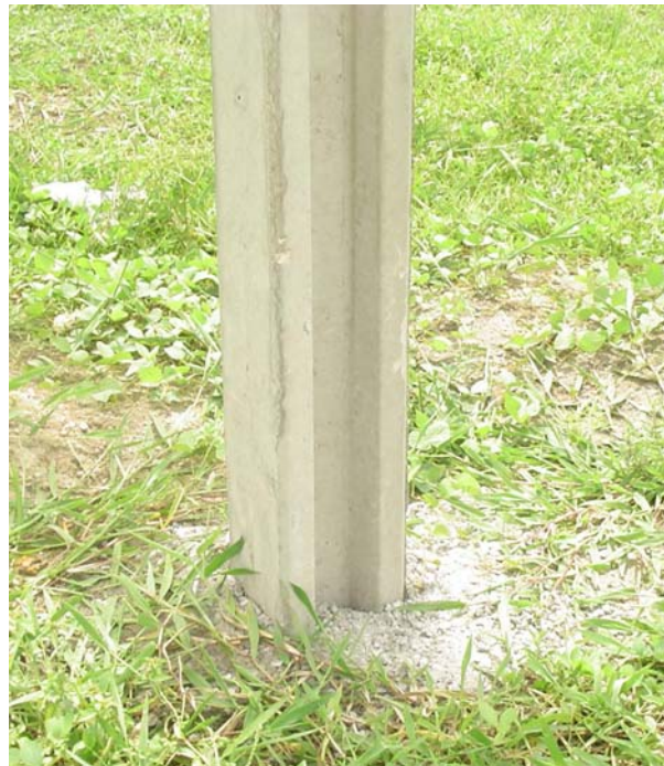
Figura 4.5 – Seção transversal em H do pilar.
