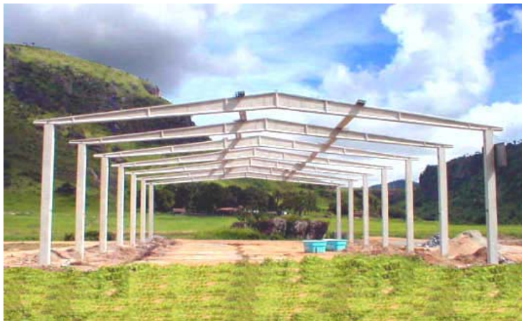
Figura 2.5 - Sistema aporticado com viga de cobertura contínua.
