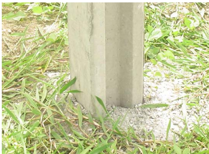
Figura 4.8 – Fundação tipo cálice utilizada no galpão.
