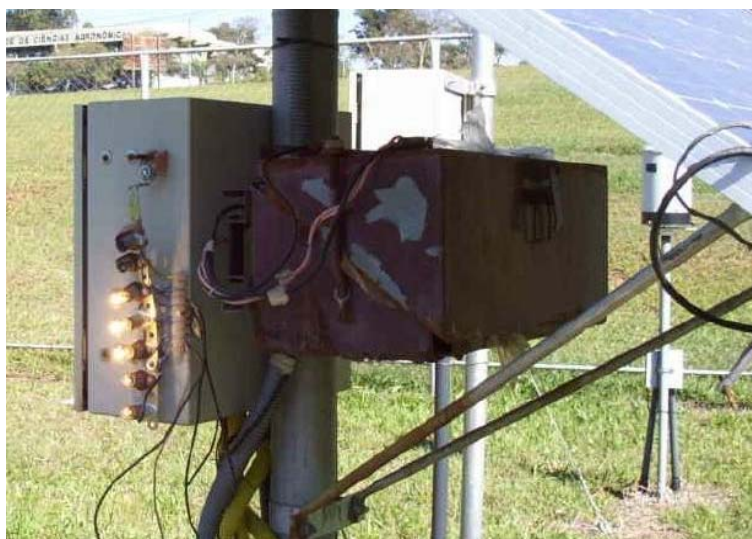
Figura 15. Detalhe da instalação das cargas de iluminação em corrente contínua e da bateria.
