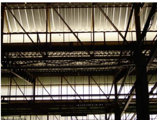
Figura 35 - Shed visto do interior.
