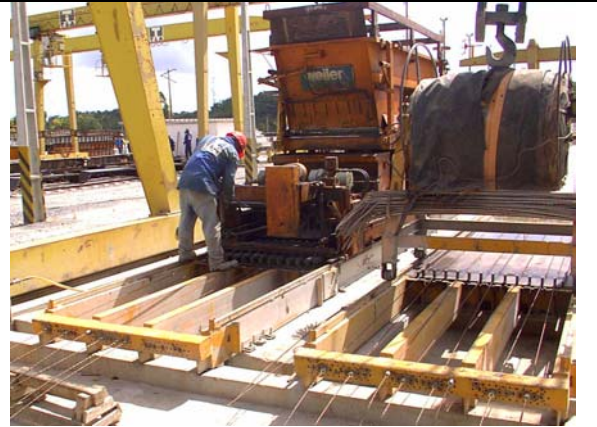
Figura AP-D-16 – Início concretagem
