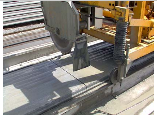
Figura AP-D-12 – Corte de laje
