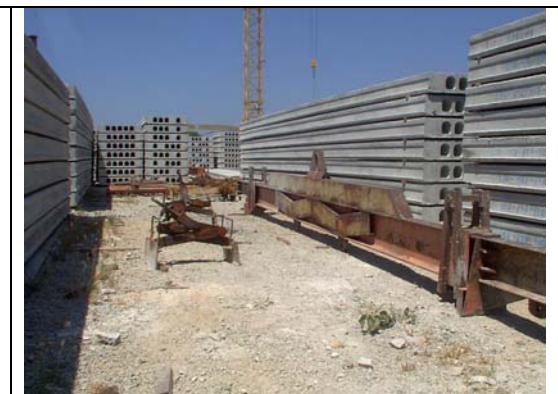
Figura AP-D-8 – Viga metálica e prensas
