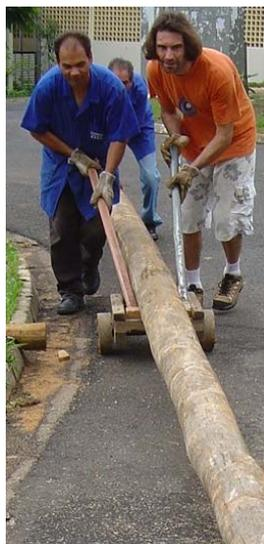
Figura 22 – Condução da peça roliça de madeira ao trilho de suspensão.
