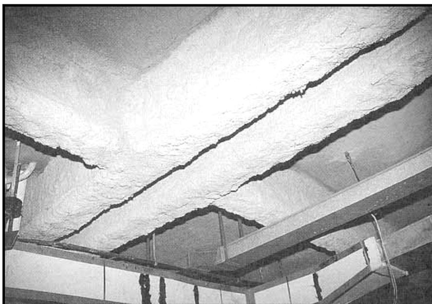
**Figura 3.12** – Argamassa à base de vermiculita. Fonte: SILVA (2001).
