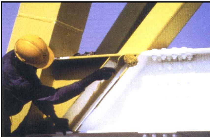
**Figura 3.24** – Aplicação da tinta intumescente. Fonte: DIAS (2002).
