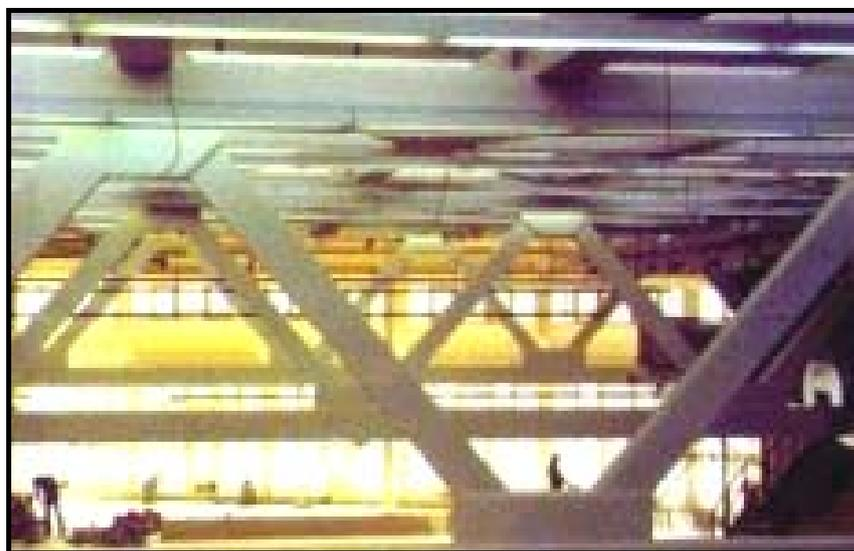
*Figura 3.20* – Estrutura protegida com placas rígidas de painéis autoclavados.
