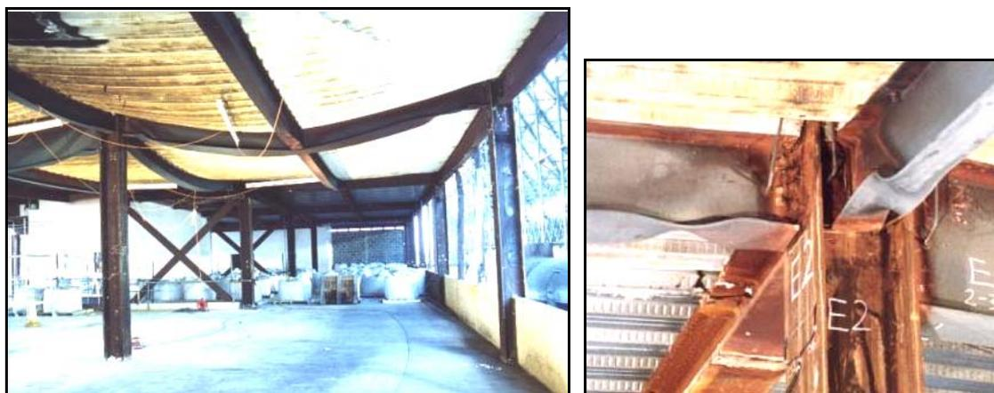
**Figura 2.2** - Vista geral de um dos pavimentos e configuração deformada dos elementos estruturais após o incêndio. Fonte: SCI (2000).
