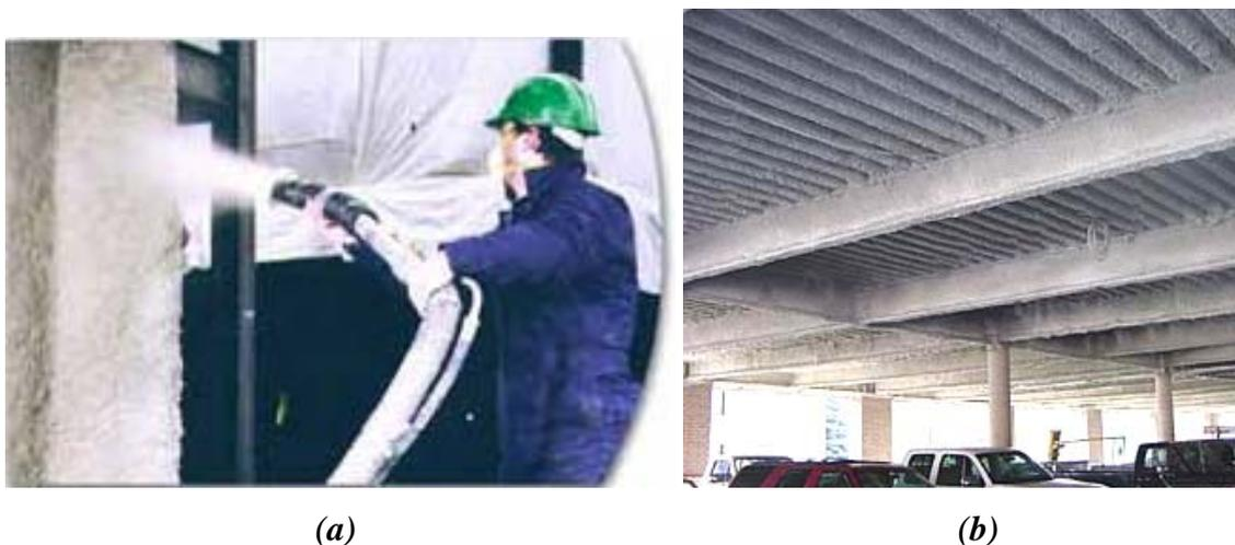
**Figura 3.13** – Fibras projetadas (BLAZE-SHIELD®): (a) Operação de jateamento. Fonte: [isolatek.com](http://isolatek.com); (b) Detalhe do acabamento. Fonte: [sweets.construction.com](http://sweets.construction.com).
