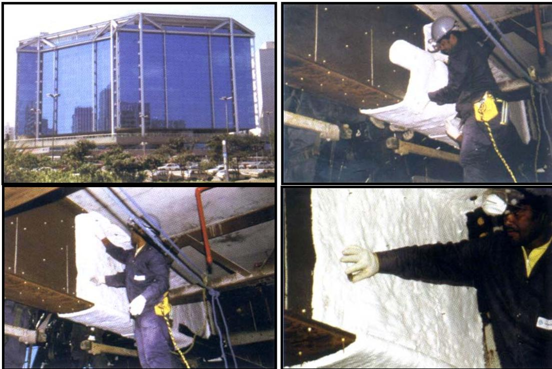
**Figura 3.22** – Centro Empresarial do Aço protegido por manta de fibra cerâmica, São Paulo – SP: vista geral e detalhes da fixação da manta de fibra cerâmica em perfil soldado tipo I, por meio de pinos e arruelas de pressão. Fonte: DIAS (2002).
