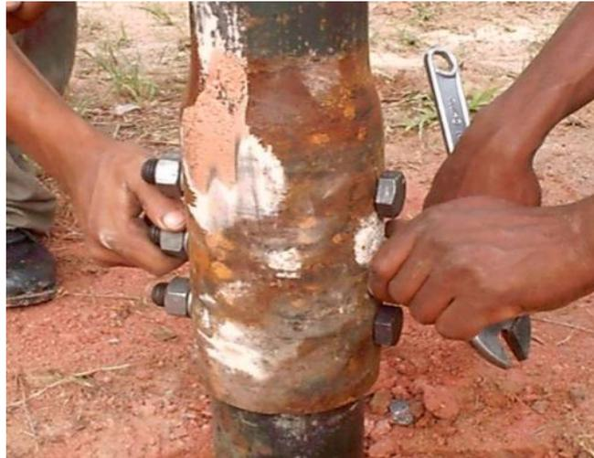
Figura 4.4 - Procedimento de emenda da estaca (Contagem)
