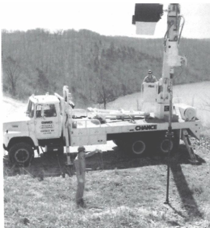
Figura 2.12 – Caminhão adaptado para a instalação de estacas metálicas helicoidais
