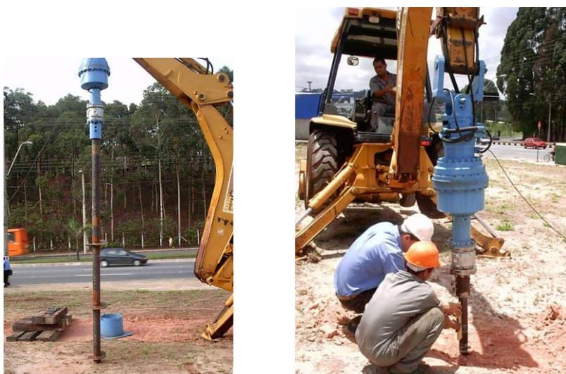
Figura 4.3 - Instalação de estaca metálica helicoidal em Contagem
