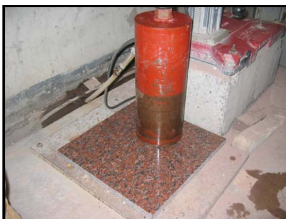
Figura 4.136 – Amostragem do corpo-de-prova de rocha utilizado no ensaio SPR.
