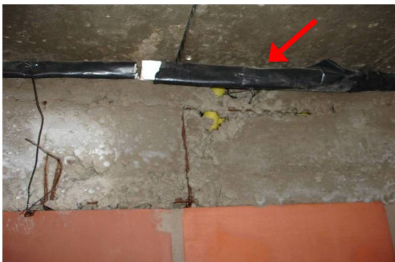
Figura 55: detalhe da junta deslizante do último pavimento sobre a cinta de respaldo
