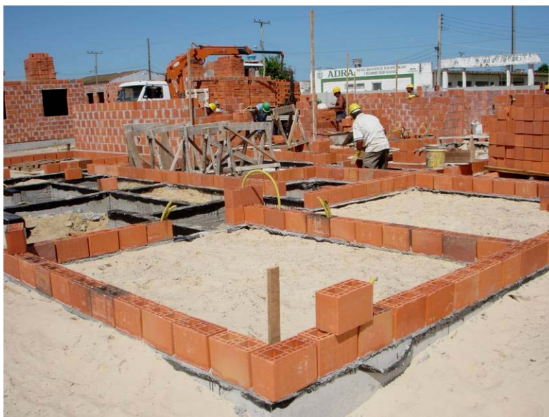
Figura 60: assentamento da primeira fiada sobre as vigas de baldrame
