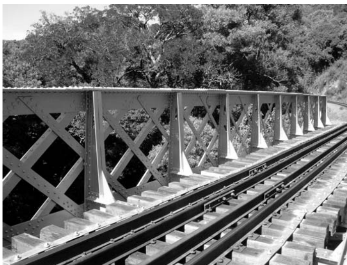
Figura (5.1) – Ponte metálica no Km 11+004, linha Santa Maria – Marcelino Ramos.
