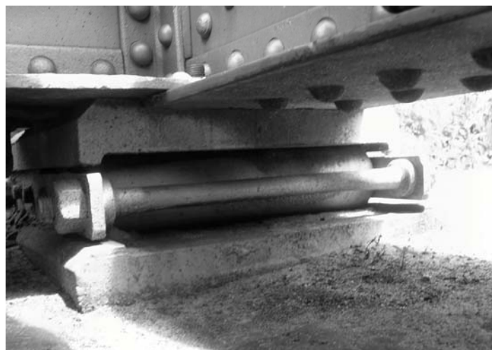
Figura (5.7) – Mecanismo de apoio.
