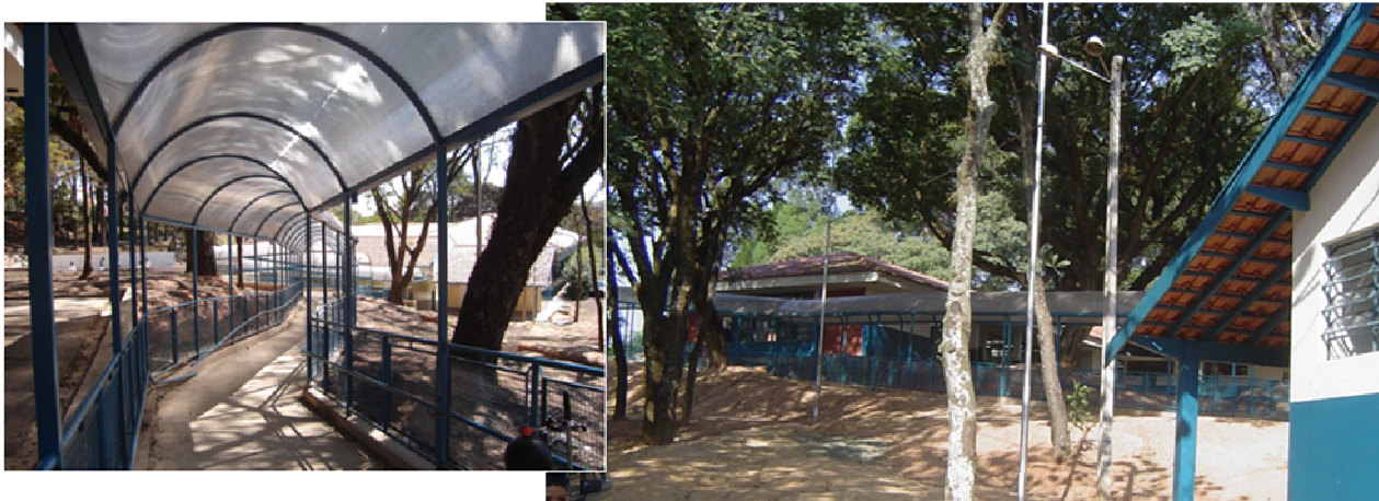
Figura 6-24: Rampa de acesso ao Bloco2
