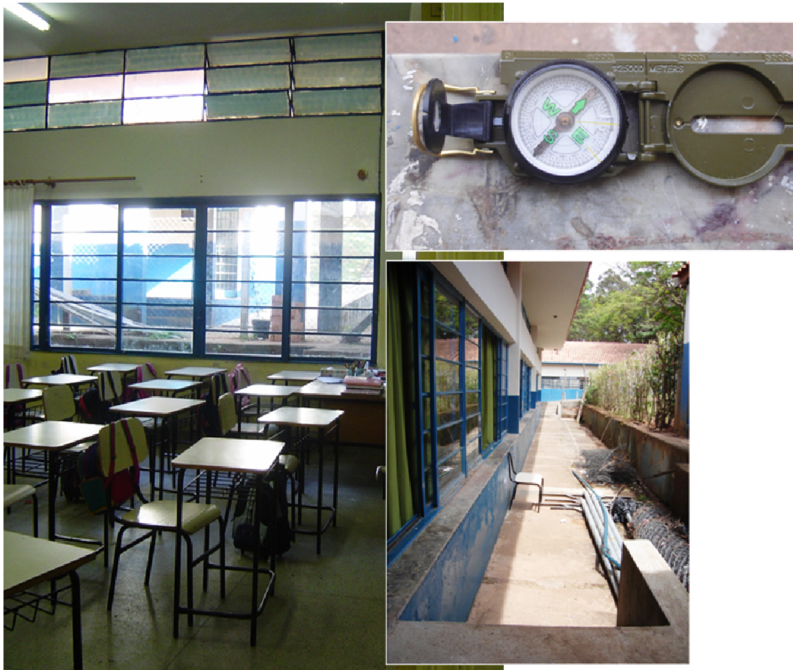
Figura 6-6- Sala 01 ORIENTAÇÃO - peitoril da janela
