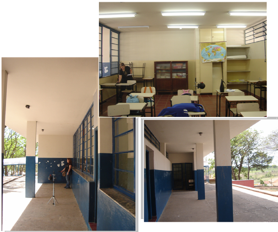
Figura 6-27- Sala 08 EMEF Raul Pilla
