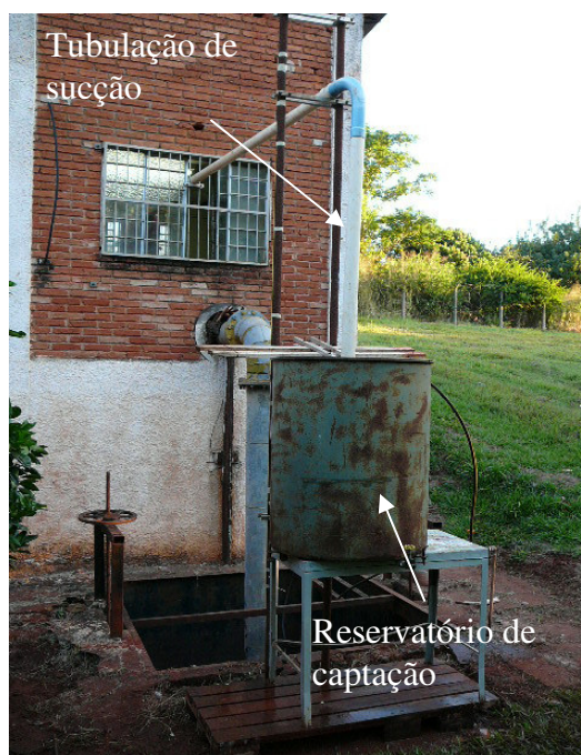
FIGURA 12. Vista geral do reservatório de captação a dois metros de altura geométrica de sucção (hgs).
