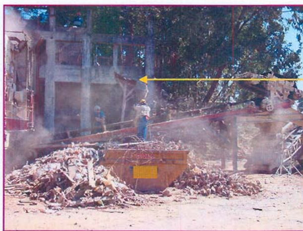
FIGURA 8 – Triagem na esteira transportadora e posicionamento do eletroímã
