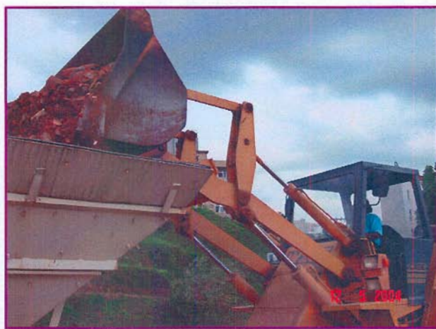
FIGURA 7 – Depósito do material no britador
