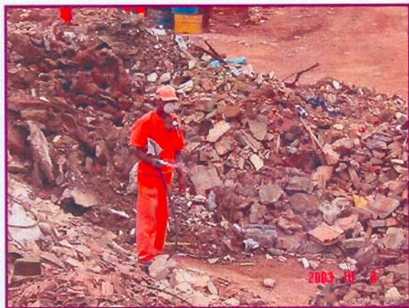
FIGURA 30 – Usina A – Pré-triagem no pátio de descarga do entulho
