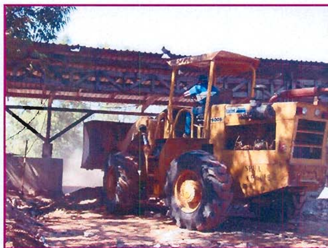
FIGURA 34 – Usina C – Operador da pá carregadora alimentando o britador
