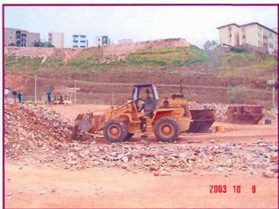
FIGURA 28 – Usina A – Operador da pá carregadora retirando o entulho das leiras
