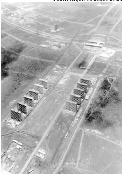
O começo da construção de Brasília: a Esplanada dos Ministérios
