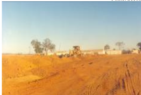
As obras têm continuidade
