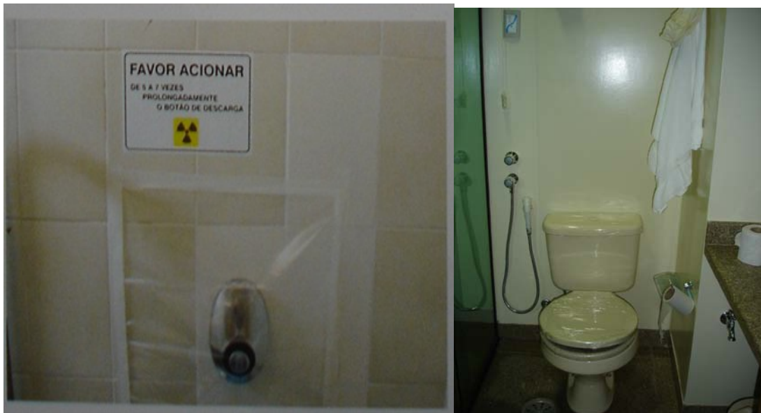
Figura 21. Proteção do vaso sanitário e da válvula de descarga, com aviso destacado de acionamento da mesma após o uso, no Hospital B.
