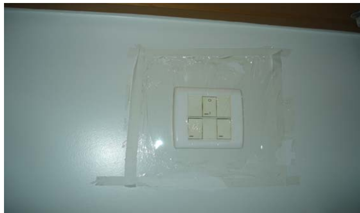
Figura 24 . Medidas de radioproteção para acessórios, com proteção de plásticos impermeáveis e forrações.
