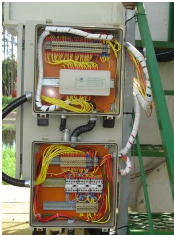
FIGURA 19. Centro de operações do controle lógico programável (CLP), utilizado para monitorar os equipamentos integrantes do sistema piloto de tratamento da água residuária do café, localizado no NECAF/UFLA.
