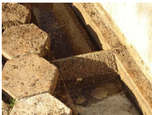
FIGURA 5. Tratamento preliminar componente do sistema piloto de tratamento da água residuária do café, localizado no NECAF/UFLA.
