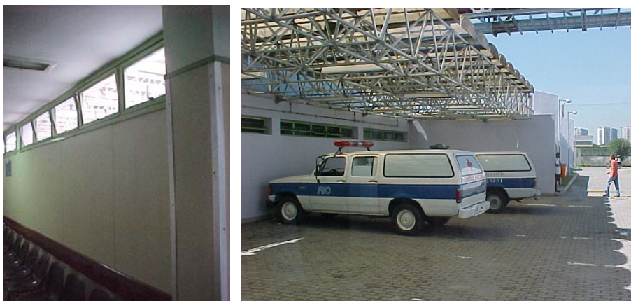
Figs. 53 e 54: Área de espera e bloco do setor de imagens do Hospital Lourenço Jorge Fonte: Espaço Saúde, 2003
