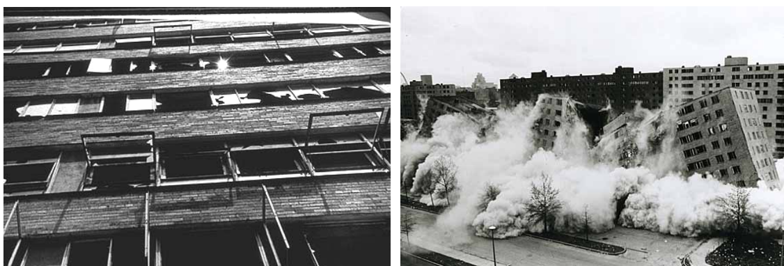
Figs. 01 e 02: Implosão do conjunto Pruitt-Igoe; detalhes do conjunto Fontes: NEWMAN, 1996 :11-12
