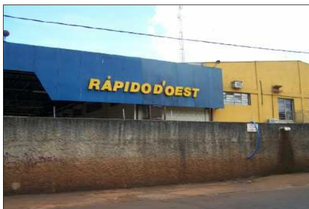
Figura 36. Cano de água que escoar as águas das enchentes na empresa de ônibus (Foto do autor, 10/01/2006).
