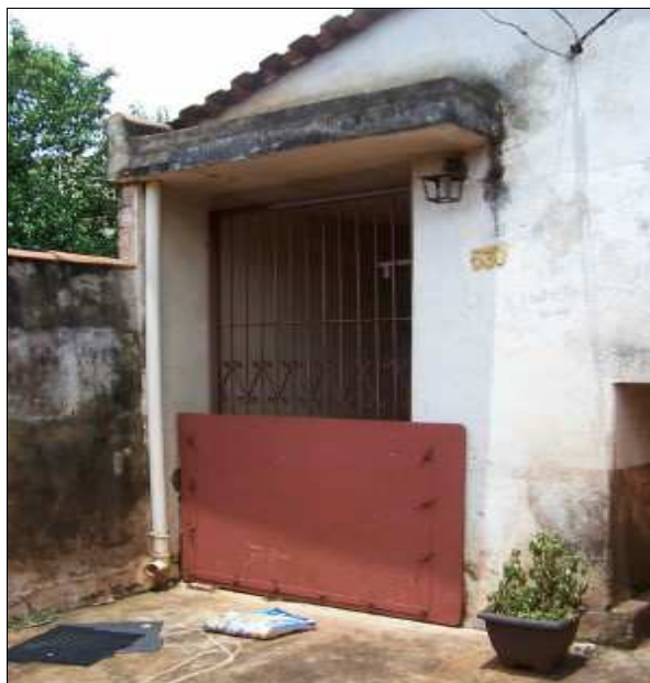
Figura 34. Sistemas de eclusas utilizados pelos moradores da Vila Virgínia para conter as inundações (Foto do autor, 10/01/2006).
