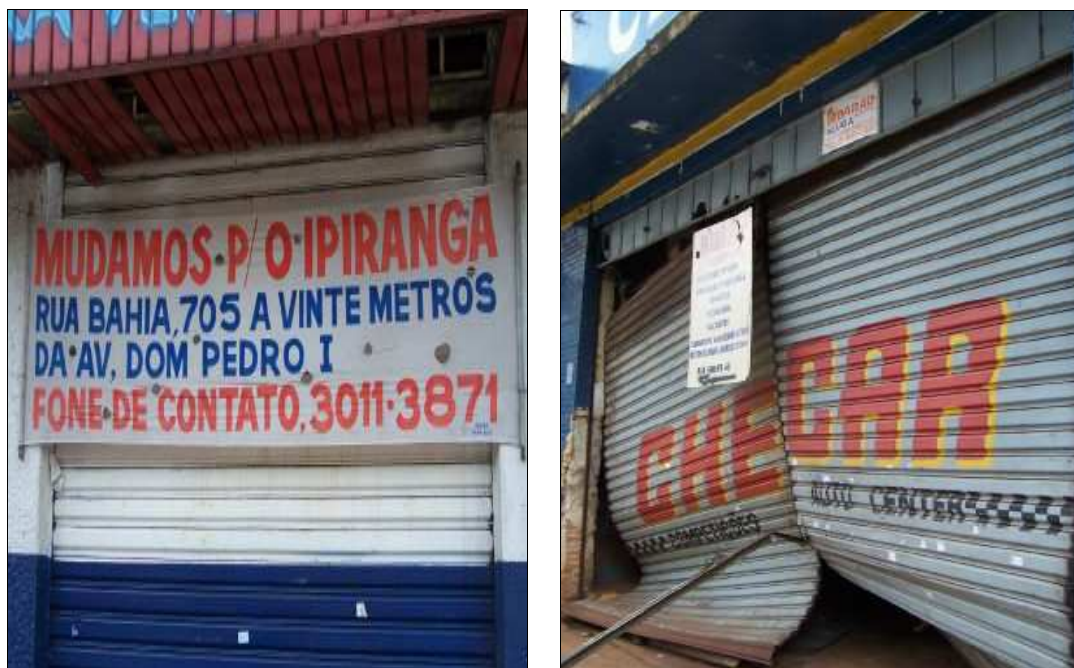
Figura 46. Estabelecimentos comerciais abandonados na avenida Francisco Junqueira (Foto do autor, 10/01/2006).
