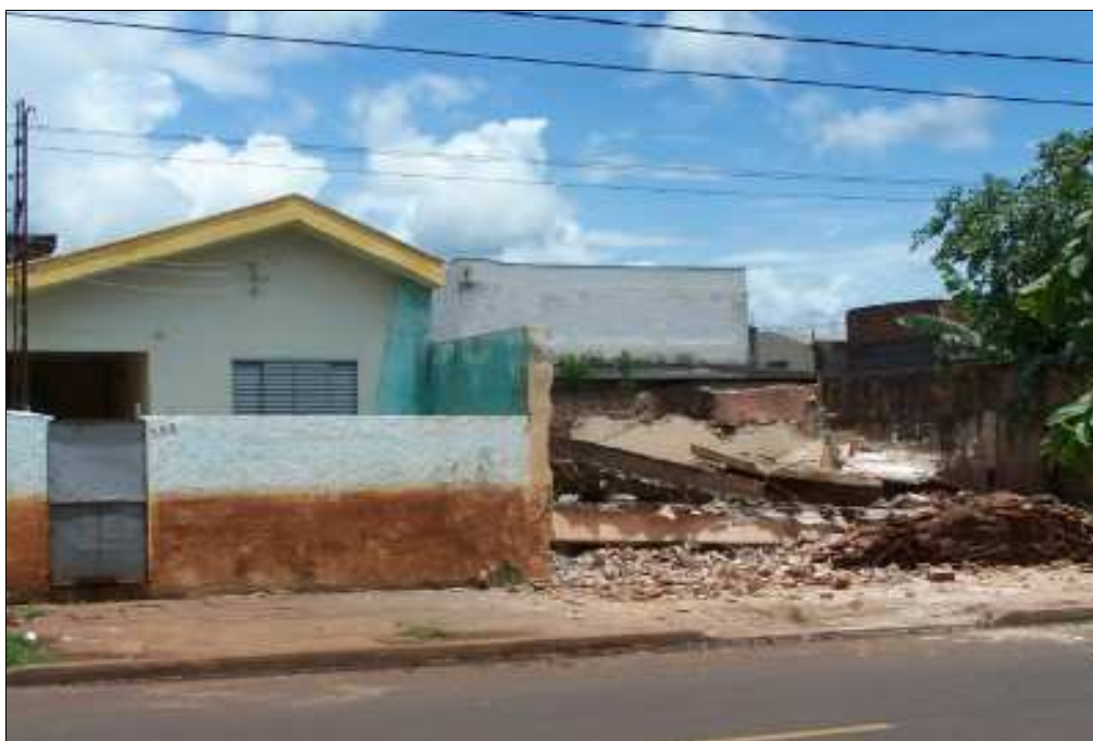
Figura 33. Indicação da altura da água do córrego Ribeirão Preto e residência em demolição na Vila Virgínia (Foto do autor, 10/01/2006).
