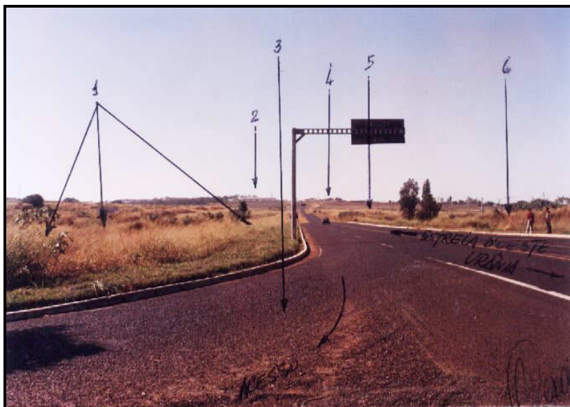
Figura 69 – Vista da área desapropriada – 1987
