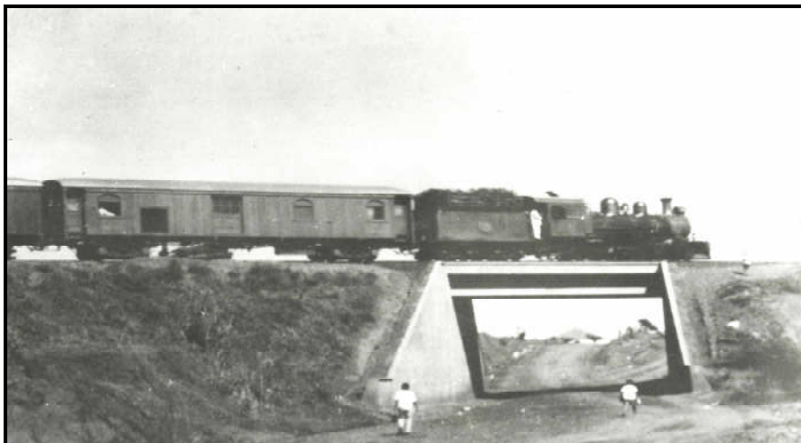
Figura 51 – Pontilhão sobre a Avenida Marimbondo – 1952 Fonte: Projeto Memória, nº 84, 2003.
