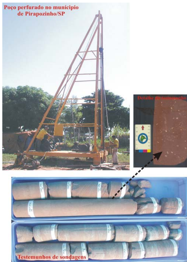
Figura 02: Fotos de testemunhos de sondagem e do poço perfurado em Pirapozinho-SP.
