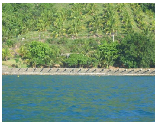
Figura 4.20: Ambiente com interferência antrópica presente na face oeste Ilha de São Sebastião. Estrutura artificial lisa, ISL 1.
