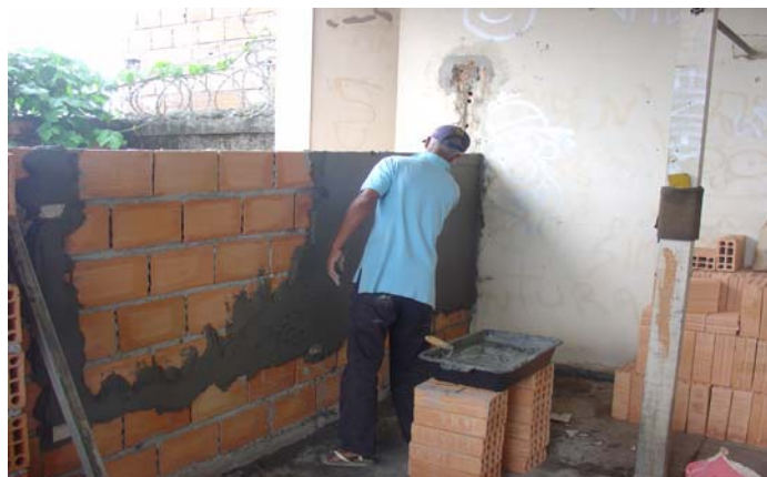
FIGURA 18 - Aplicação das argamassas de revestimento (sem chapisco).
