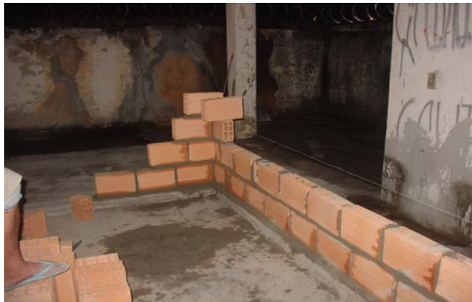
FIGURA 14 - Execução da alvenaria para revestimento argamassado sobre base cerâmica (sem chapisco).
