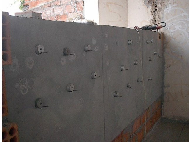
FIGURA 25 - Painéis prontos para execução dos testes de arrancamento e extração dos testemunhos para avaliação microestrutural.
