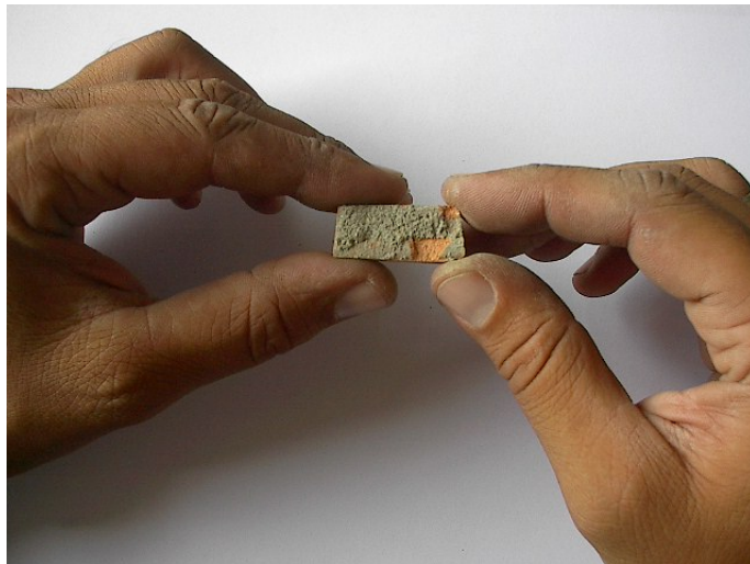
FIGURA 30 - Superfície do bloco cerâmico da amostra (para análise no MEV) após a retirada do revestimento argamassado.
