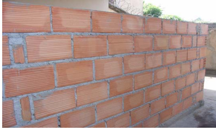
FIGURA 16 - Painéis prontos para aplicação das argamassas de revestimento (sem chapisco).
